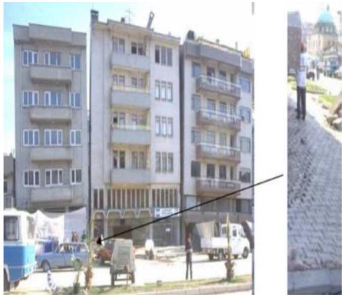
Figure I.23 : Tassement du bâtiment
