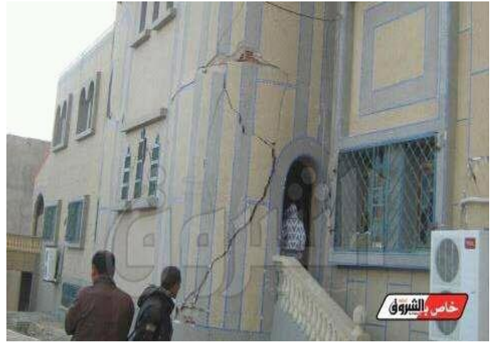
Figure I.19: Effondrement de la maçonnerie
