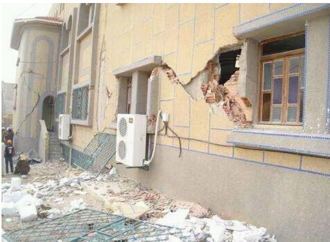
Figure I.18: Fissure en X de la maçonnerie
