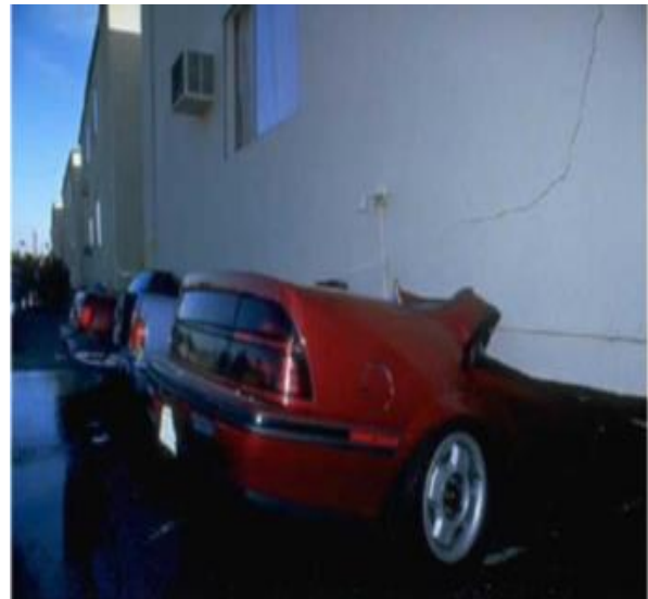
Figure I.22 : Cisaillement de l'étage souple.
