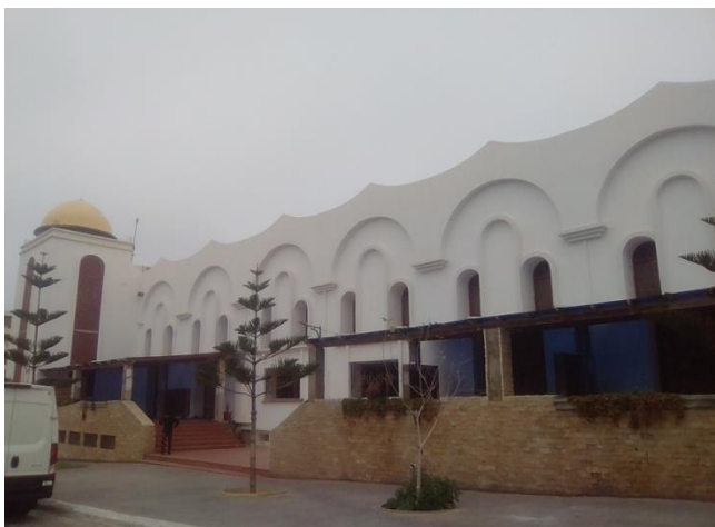
Figure 4.7 : Mosquée AL Qods
