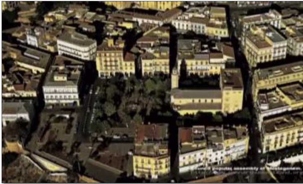
Figure 51 : vue sur la place
