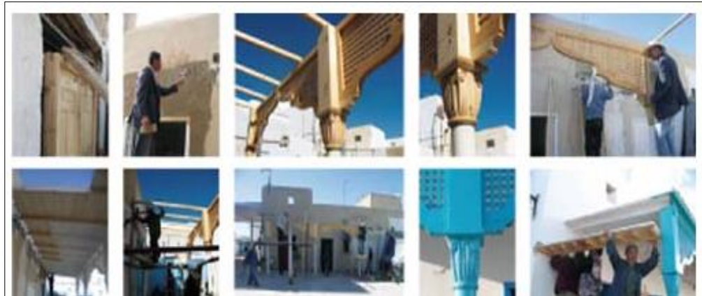
Figure 117 : les travaux de l'aménagement de la place
