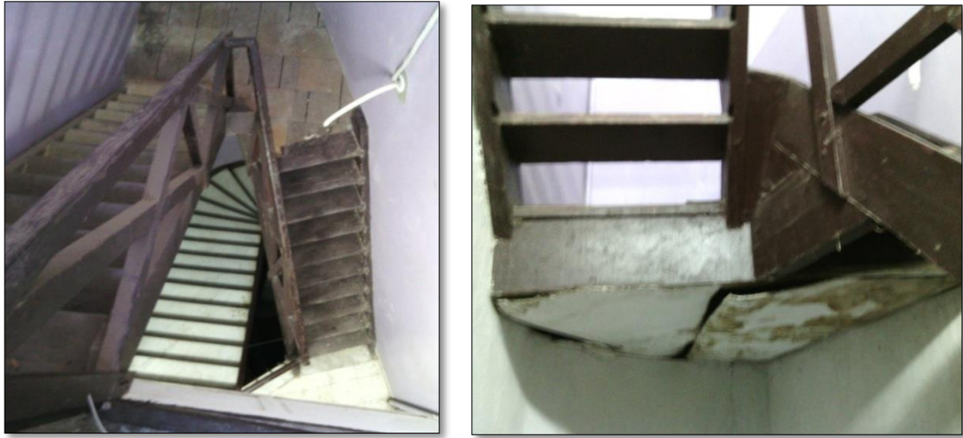
Figure 86 / 87 cage d'escalier /auteurs 2017
