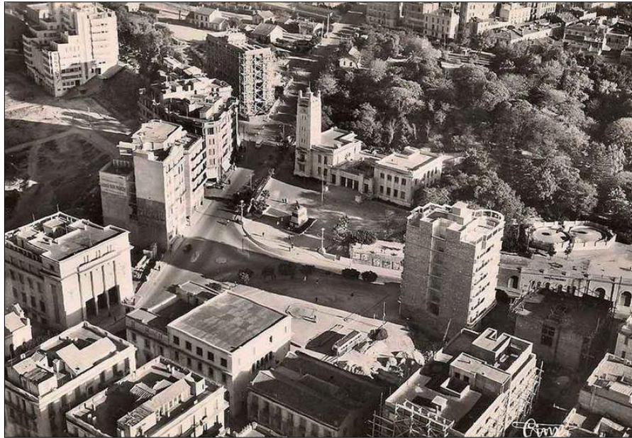
Figure 77 : Vue aérienne historique de centre-ville
