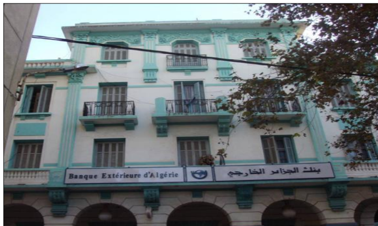
Figure 69 : Vue de la façade de l'immeuble du BEA
