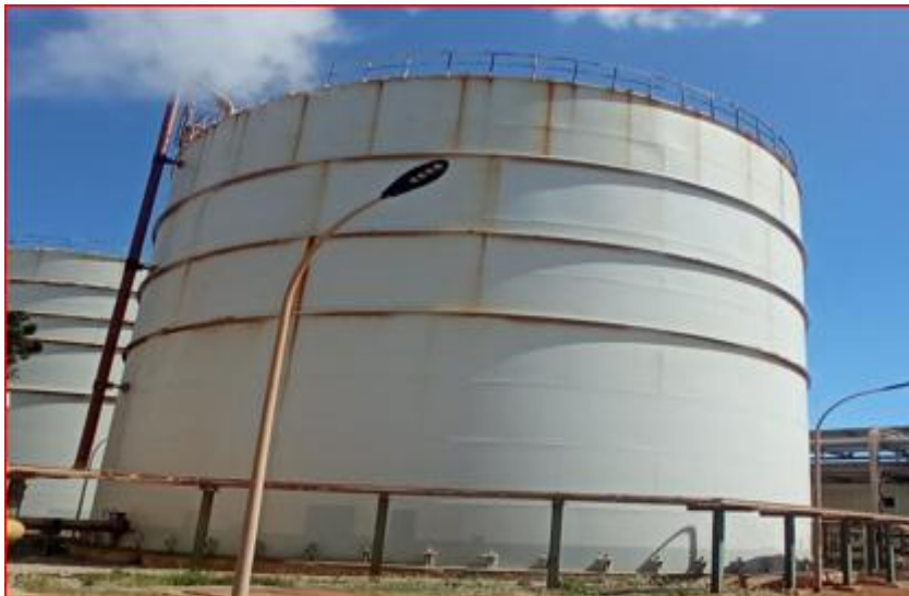
Figure I. 5: Photo de réservoir d'eau dessalée.
