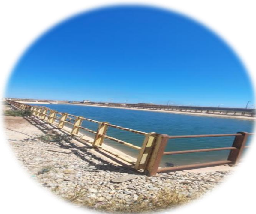
Figure III. 3: Bassin des rejets liquides du complexe.
