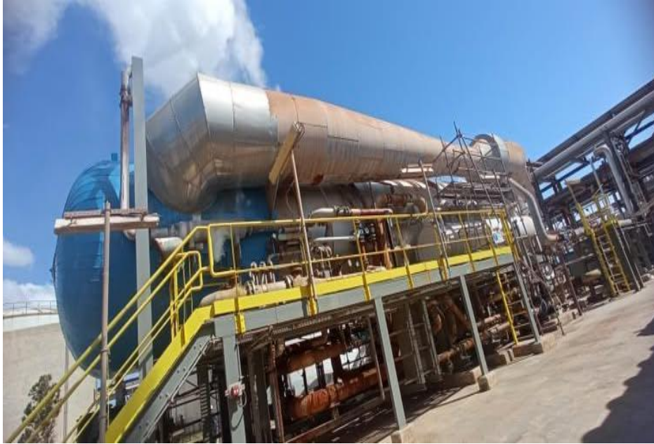
Figure I. 4: Photo de l'unité de dessalement par thermo-compresseur
