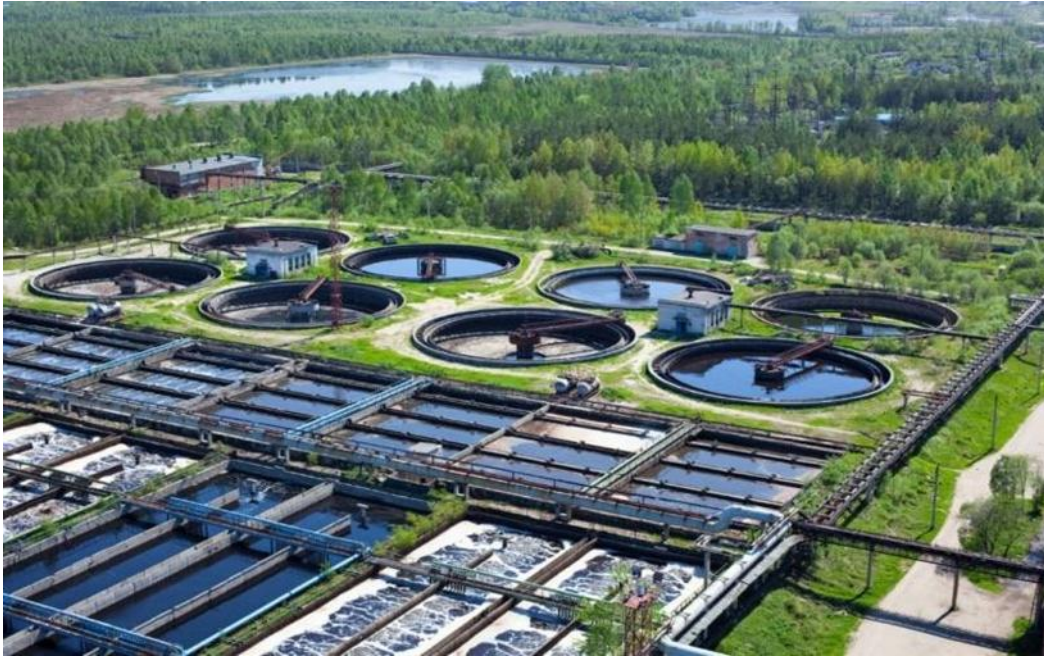
Figure II. 4: Station d'épuration des eaux usées.
