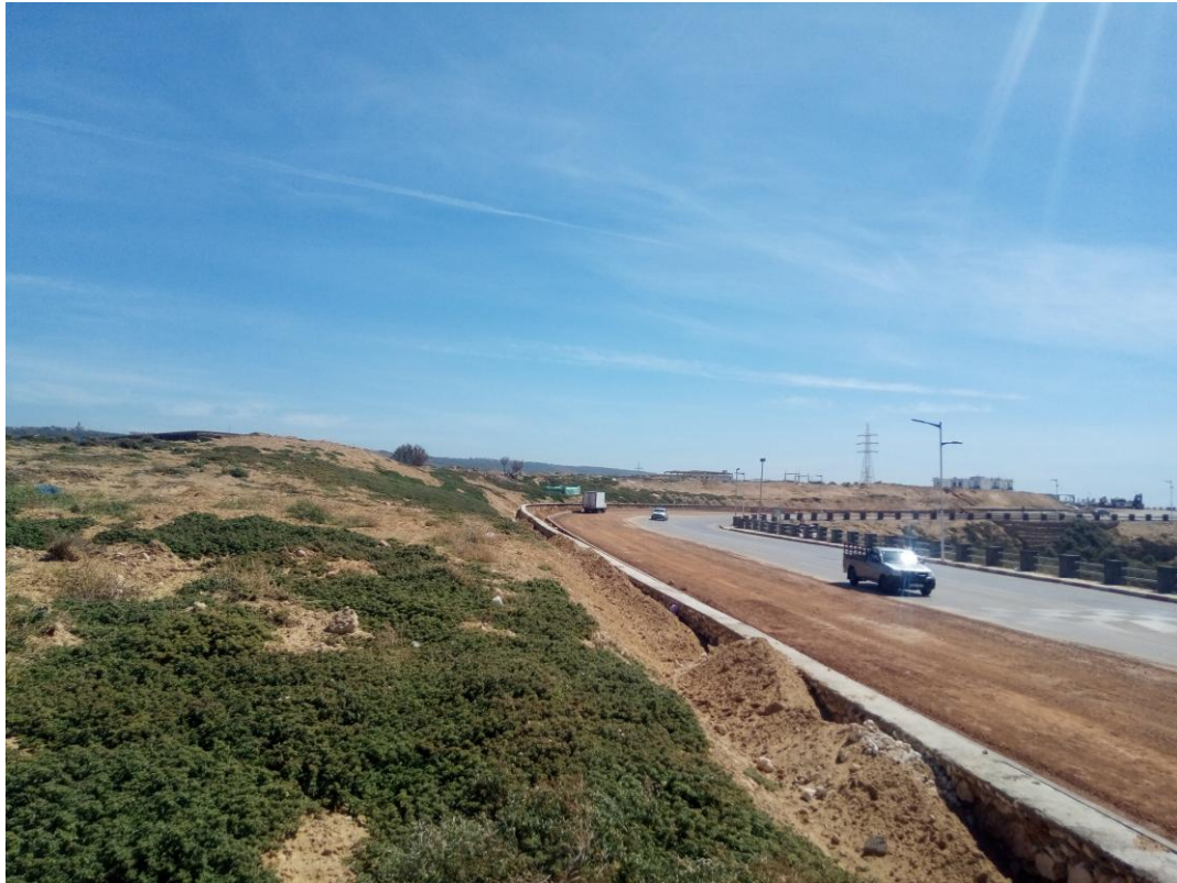
Figure 205 Photo de constat, la voie mécanique double sens
