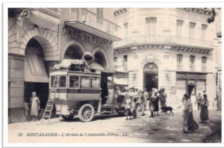
Photo 2.22 Vue historique de l'immeuble d'habitation N°3. [Ali Bettoutia,2013]
