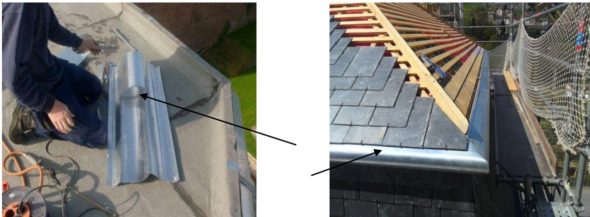
Photo 1.25 Installation de membron en Zinc
