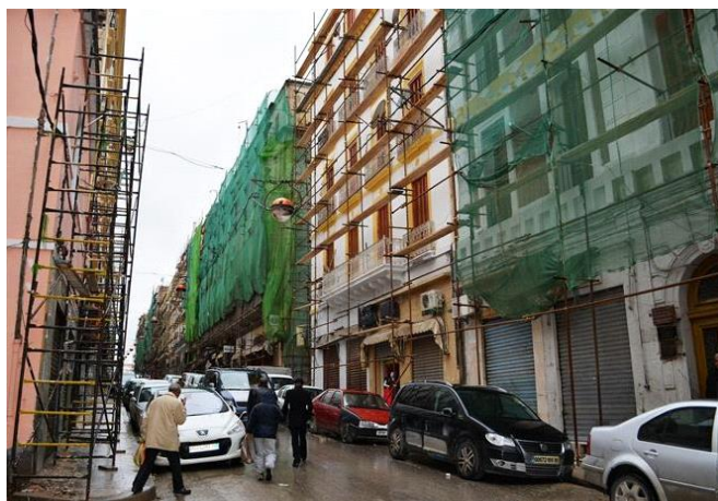
Photo 1. Bâtiments en cours et après travaux de réhabilitation-Centre-ville Mostaganem
