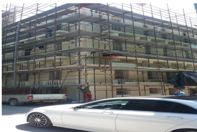
Photo 2. Bâtiment en cours et Travaux de réhabilitation-Centre-ville Mostaganem
