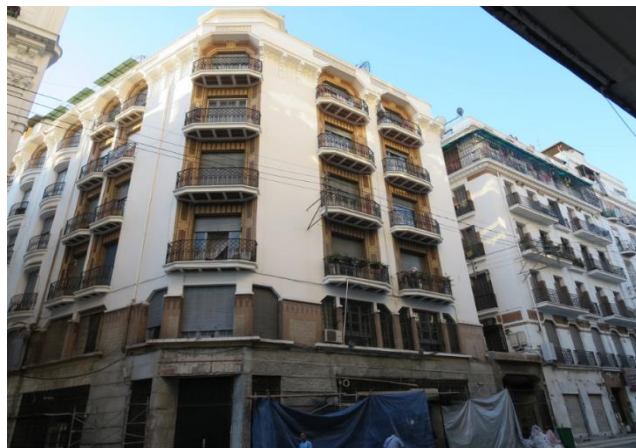
Photo 1.5. Bâtiment style art déco en cours de réhabilitation
