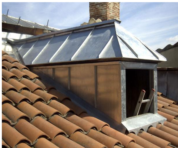
Photo1.26. Lucarne en Zinc
