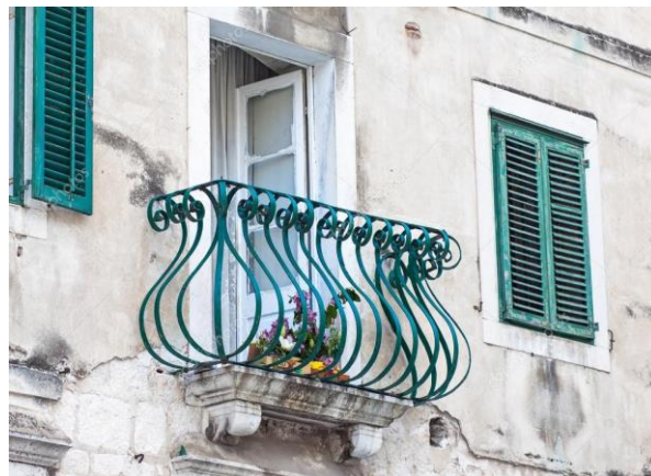
Photo 1.32. Garde corps d'un balcon isolé
