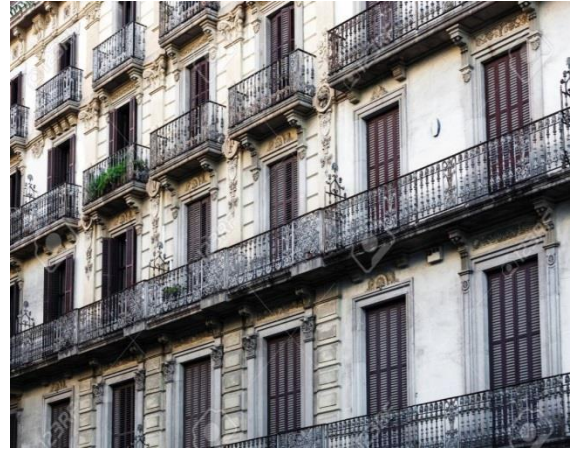
Photo 1.31. Bâtiment colonial avec deux types de balcons
