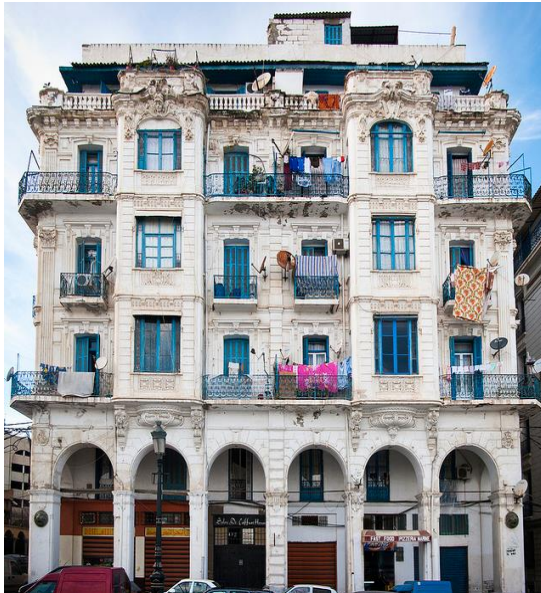
Photo 1.3. Bâtiment style art nouveau à Alger
