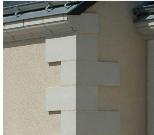
Photo1.33. Chaîne d'angle en pierres taillées
