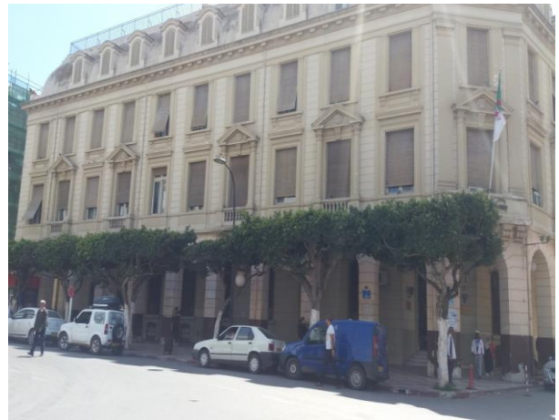
Photo 1.11. Habitat collectif colonial Mostaganem
