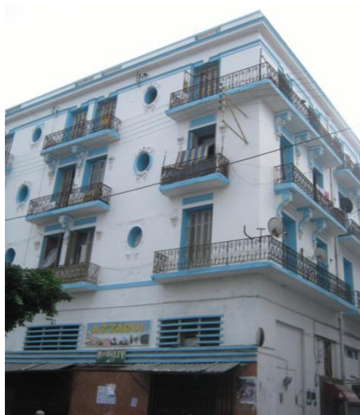
Photo 2.16 Vue de l'immeuble d'habitation N°2.
