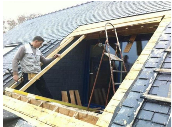
Photo 1.28. Installation d'un Châssis de toit
