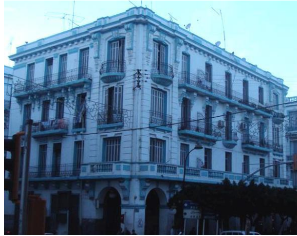
Photo 2.13. Vue de l'immeuble d'habitation N°1
