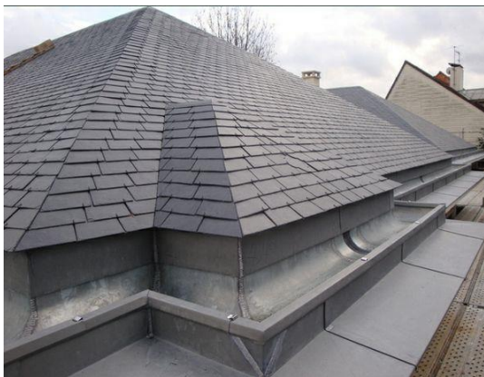
Photo 1.30. Chéneau de toit
