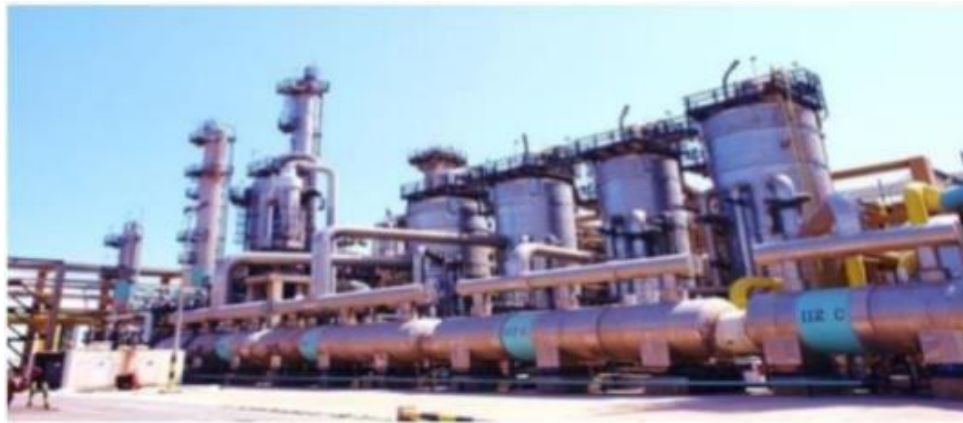
Figure I- 4: Zone des utilités.
