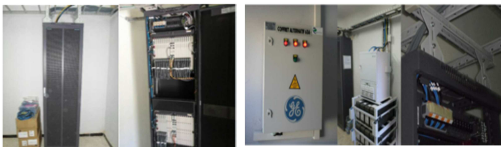
Fig. 2.4 : L'équipement MSAN et son alimentation
