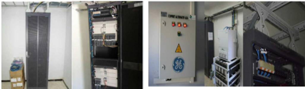
Fig. 2.4 : L'équipement MSAN et son alimentation
