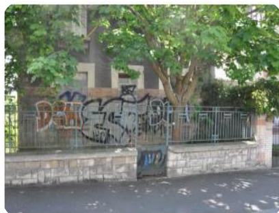
Figure 8: Une maison murée depuis plusieurs années
