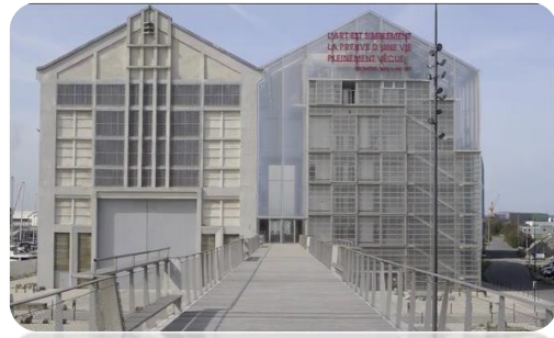
Figure 15: bâtiment du Frac / AP2 [25]
