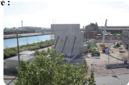
Figure 69: travaux de construction de la cité a dock [44]
