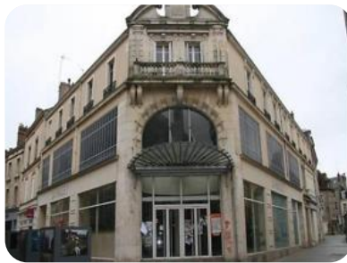
Figure 6: Bâtiments commerciaux en friche à Alençon
