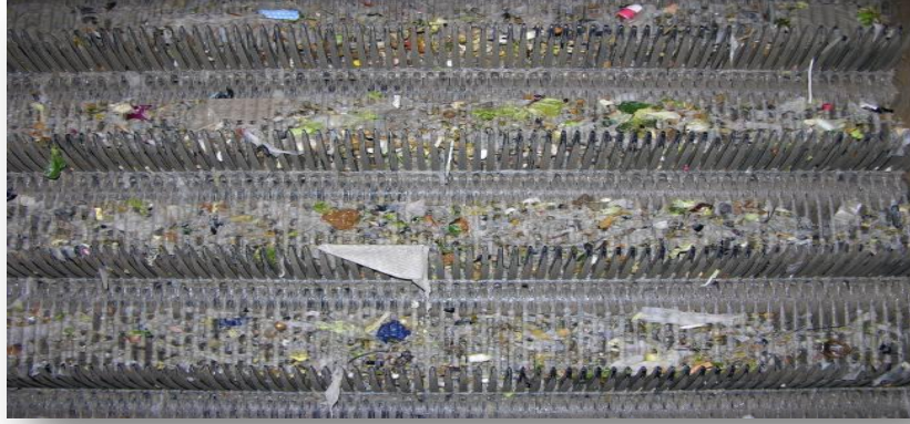
Figure 5 : le Dégrillage
