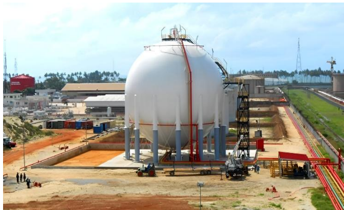
Figure I. 7: Sphère de Stockage
