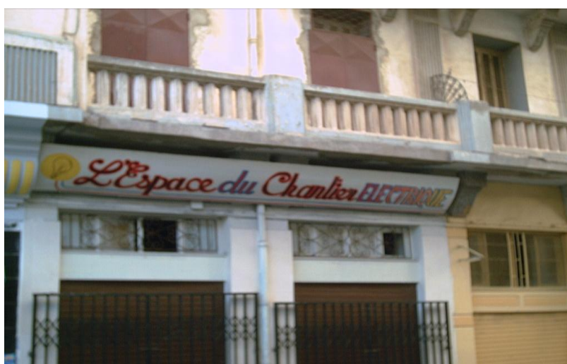
Photo 7[L'Espace du Chantier ELECTRIQUE]
