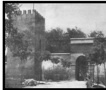
Fig : Porte des carrières
