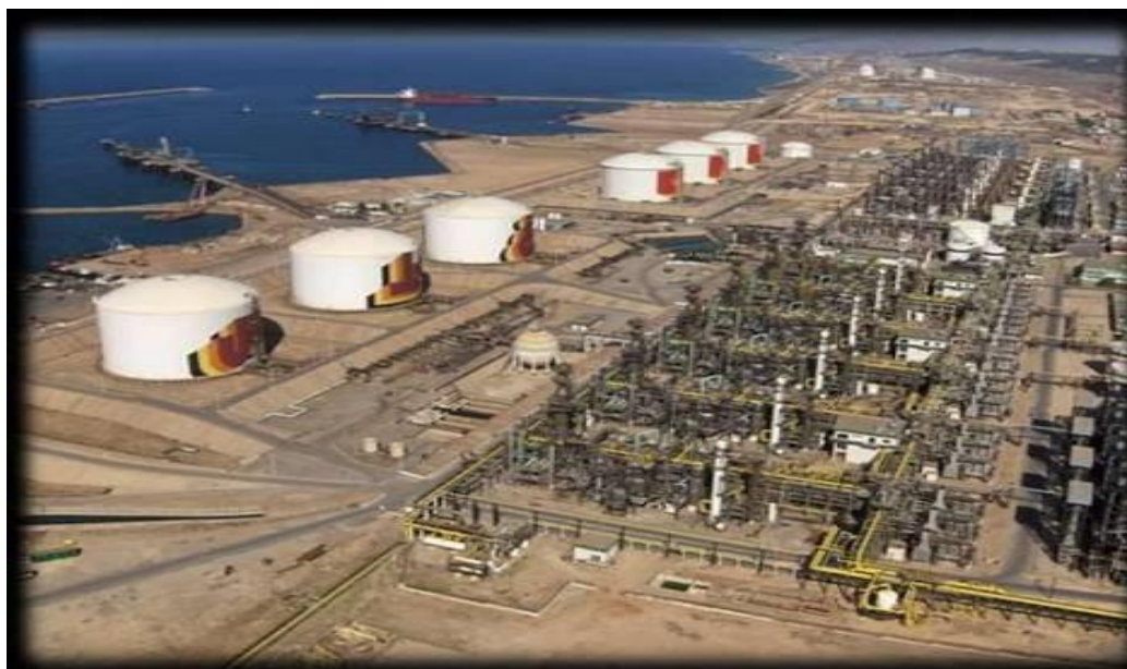
Figure I.1: La zone industrielle d'Arzew et localisation du GL2Z.
