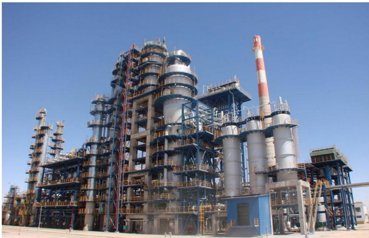
Figure II.2. Vue partielle des sections Réaction/Régénérateur et Fractionnement
