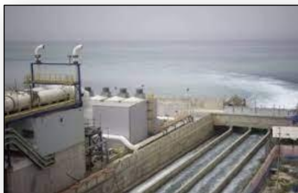
Station de dessalement d'eau De Mostaganem
