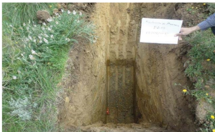
Figure VI.7: vue de fond du fouille
