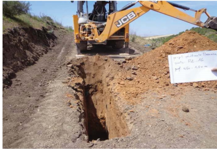
Figure VI.6 : vue l'excavatrice à l'emplacement des puits
