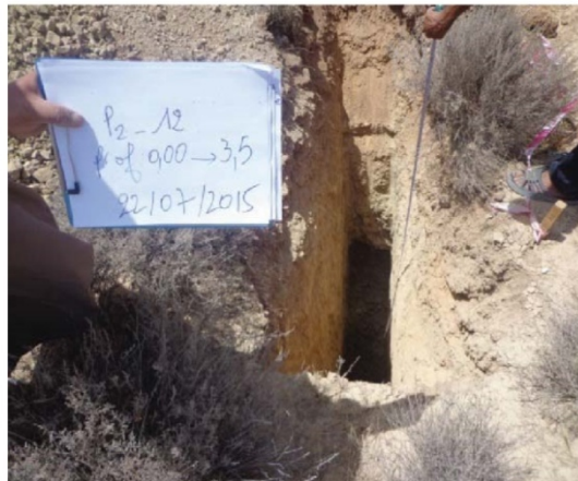
Figure VI.2 : vue de fond du fouille
