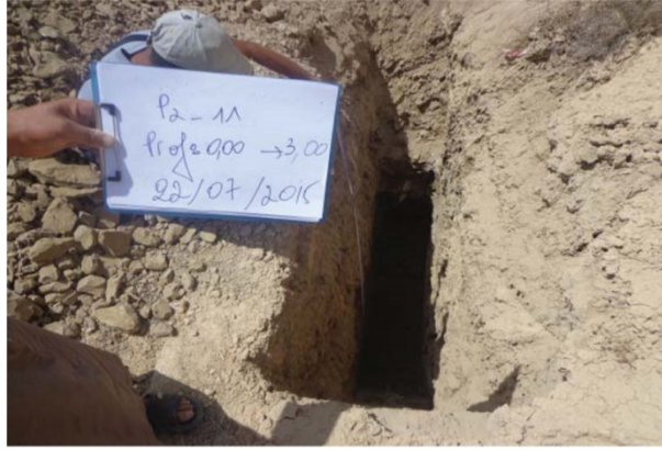
Figure VI.1 : vue du fond de la fouille
