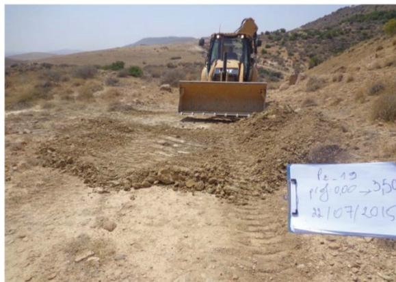
Figure VI.9 : vue de l'emplacement du puits après remblaiement
