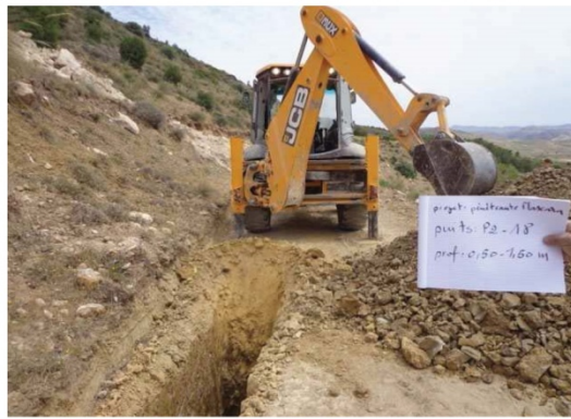
Figure VI.8: vue l'excavatrice à l'emplacement des puits
