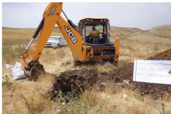
Figure VI.4 : vue l'excavatrice à l'emplacement des puits
