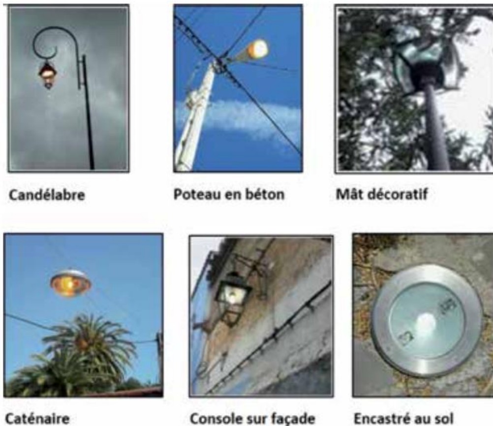
Figure II-7 les différents types de supports
