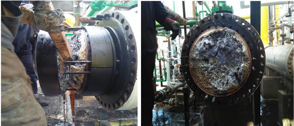
Figure 10 : Tête flottante -faisceau tubulaire coté tête flottante
