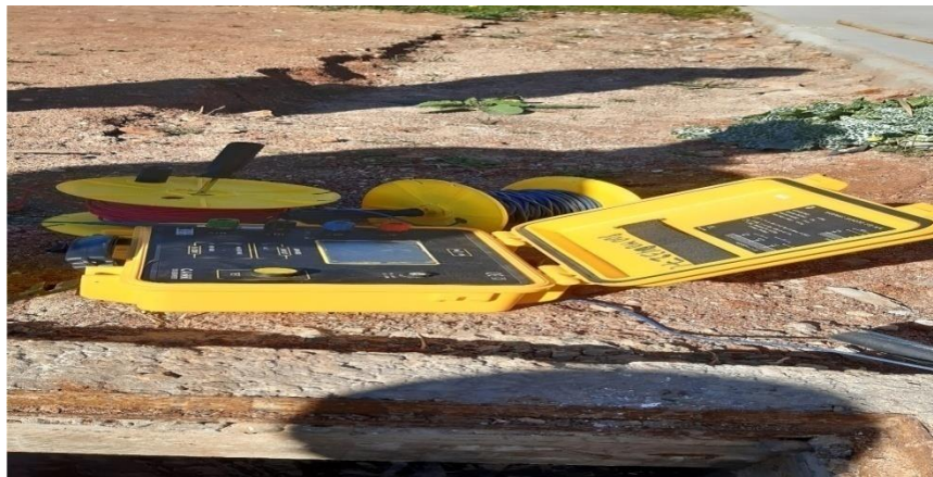
Figure 2-14 : mesure de la résistance de la terre (photo réel pendant le stage a aéroport d'Oran)
