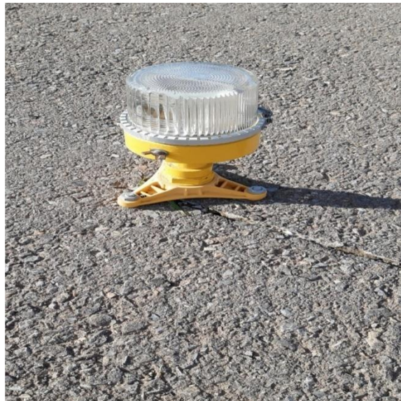
Figure.1-11 : feu de bord de piste ( source aéroport d'oran)
