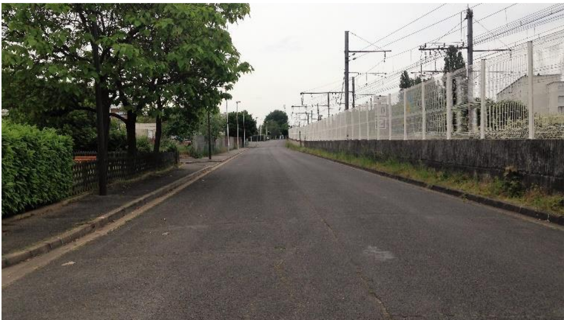
Fig. 52 : Etat existant de la rue Sanitas – Source : Auteur de l'exemple.
