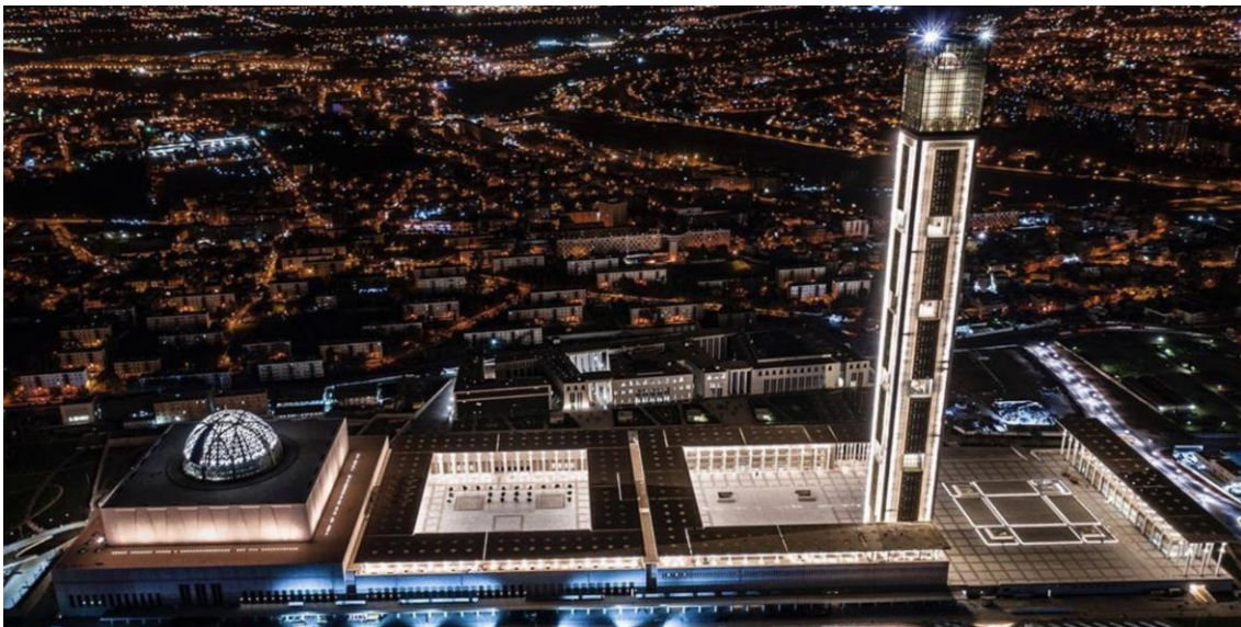
Fig. 21 : Vue globale sur la Grande Mosquée d'Alger et son minaret culminant à plus de 265m, le plus haut du monde. - Source : Instagram Cinemaxprod.
