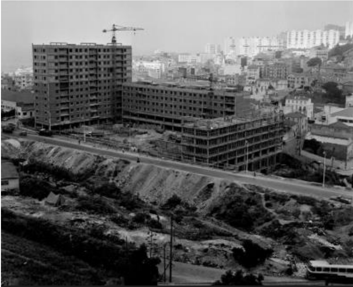
Fig. 91 : Première tranche des travaux à Diar El-Keff dans un quartier périphérique d'Alger, dans le cadre du plan de Constantine. Juillet 1959 - Source : L'application du plan de Constantine à Alger ECPAD.
