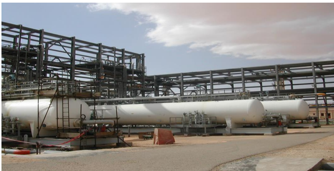
Figure I. 2: Section de séparation de brut.
