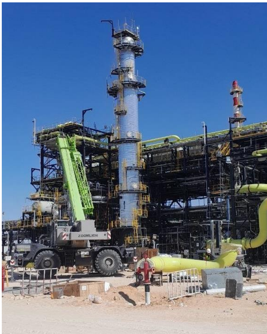
Figure I. 8: La colonne de débuteur.
