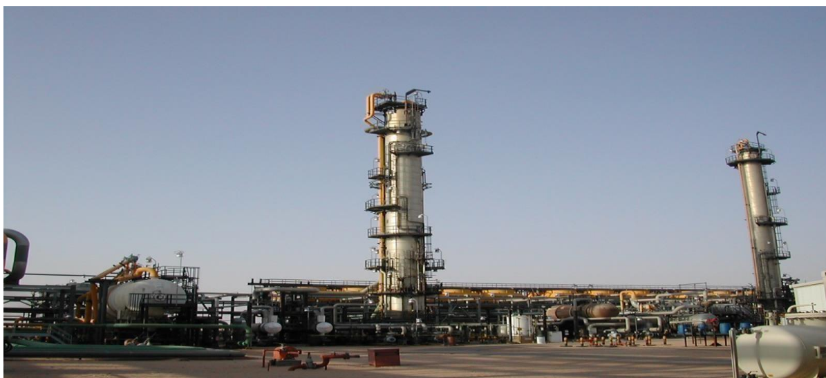
Figure I. 3: Section de stabilisation basse pression.
