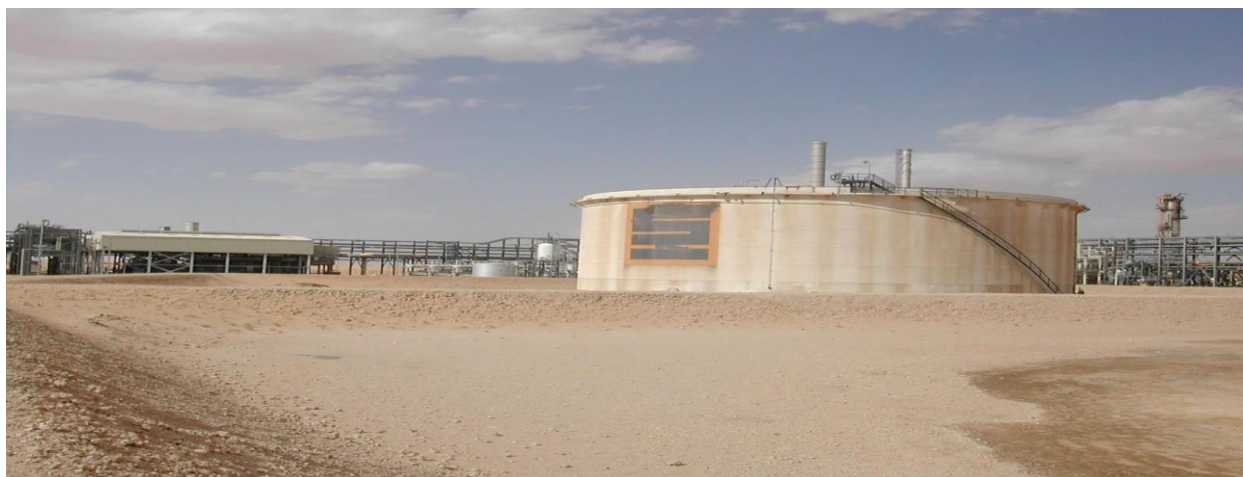
Figure I. 7: Bacs de Stockage et expédition.
