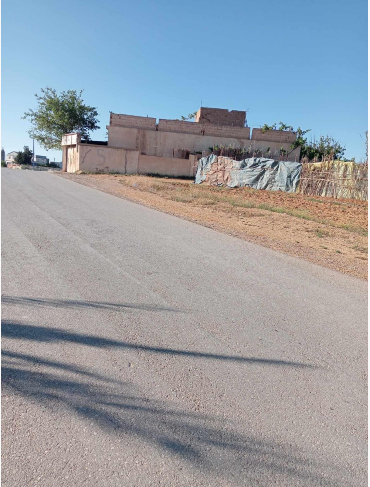
صورة رقم 8: التقرب من أحد منازل الأسر في دوار الزرارقة بلدية عشعاشة
