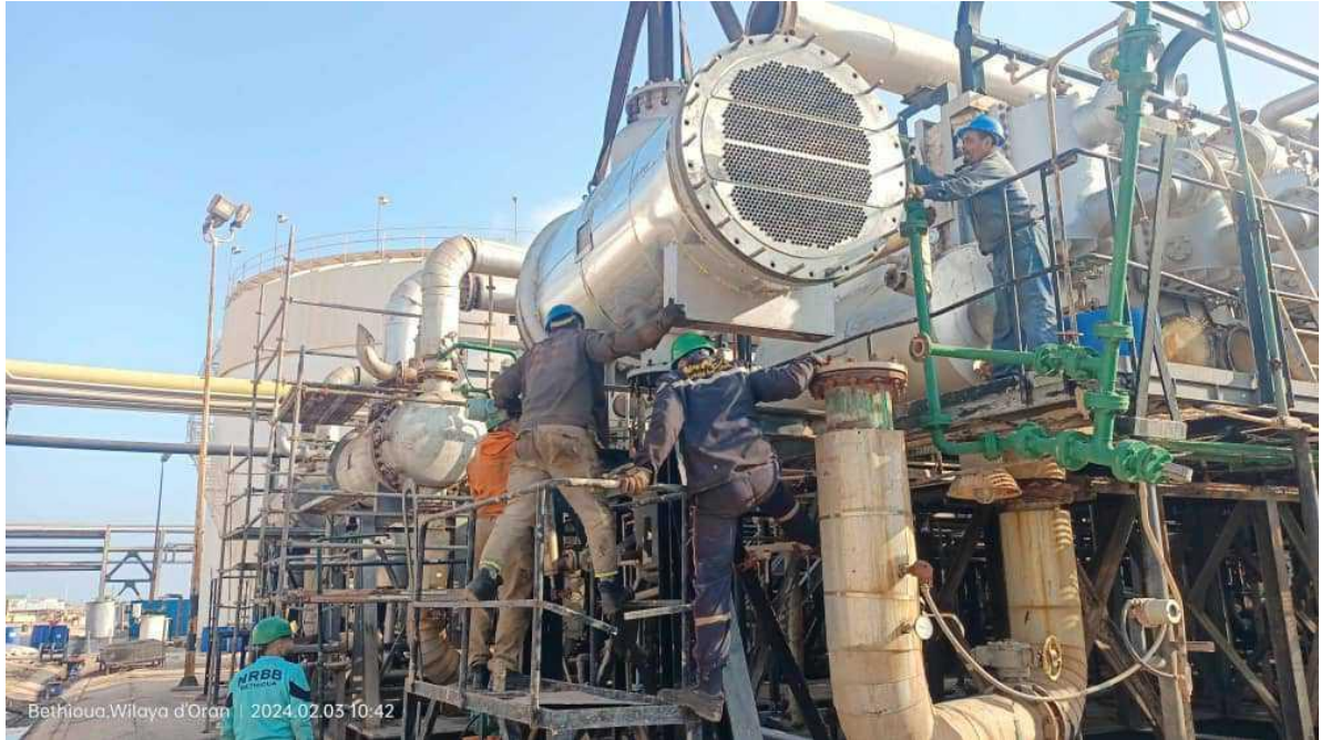
Figure II.6: Mise en place de rebouilleur sur site.
