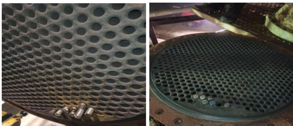
Figure II.4 : Installation de vanes pour boucher les tuyaux endommagés.
