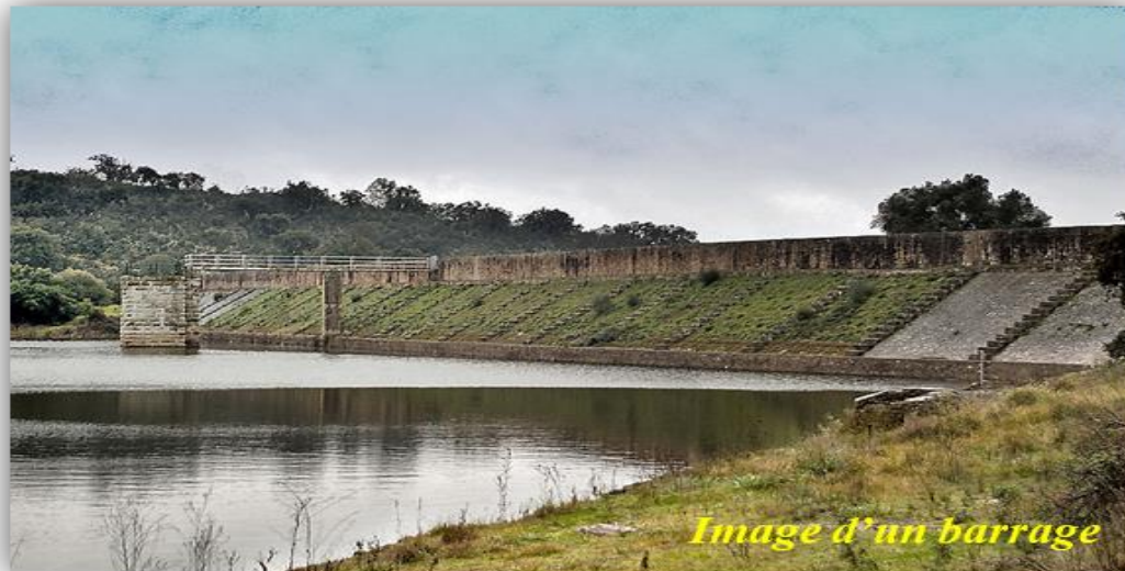
Figure 49 : vue sur u barrage / source : wikipidiya.com
