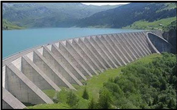
Figure 09 : image d'un barrage a contrefort/ source : universalis.fr
