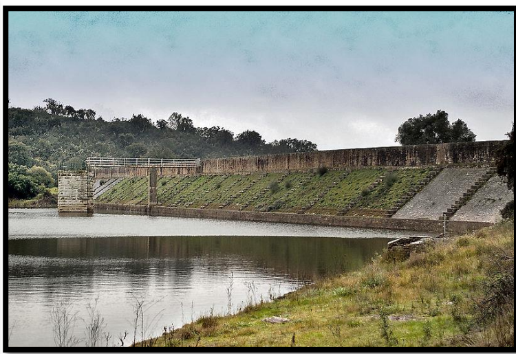
Figure 02 : vue partielle d'une cuvette/source : wikipédia.com
