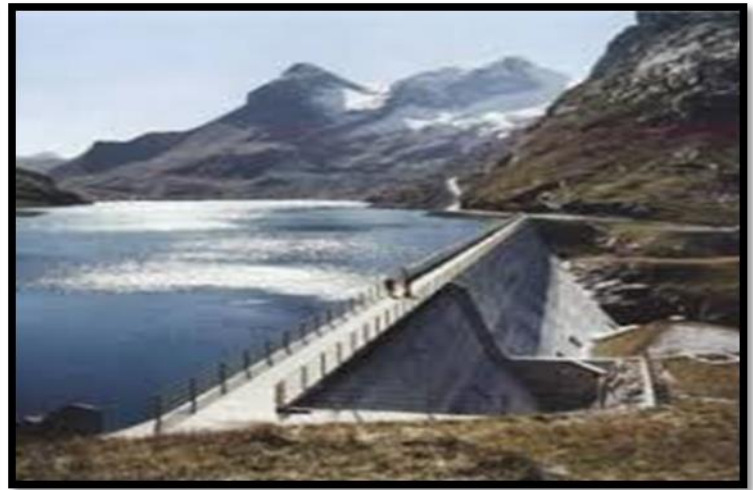
Figure 08 : image d'un barrage poids/ source : universalis.fr
