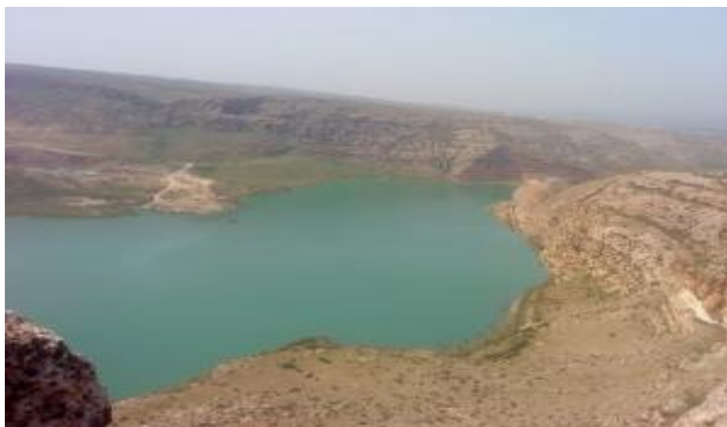
Figure16 : vue sur barrage gargar/ source : rapport de la ANBT de Oued-Rhiou
