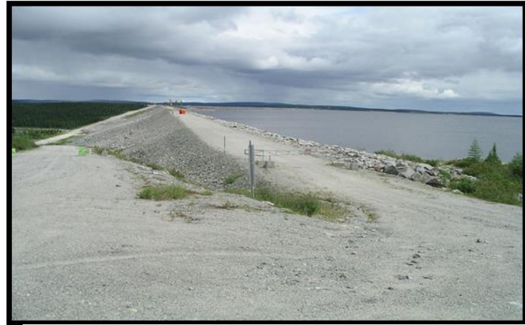
Figure10 : image d'un barrage en remblais/ source : universalis.fr
