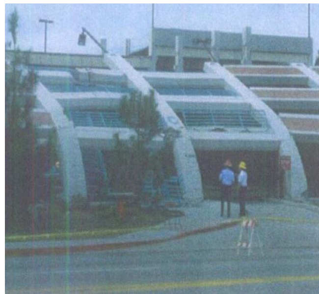
Figure I. 8 : : Effondrement par flexion hors plan d'une structure portiques en béton armé (Parking) lors du séisme de Northridge (Etats-Unis) en 1994[40].
