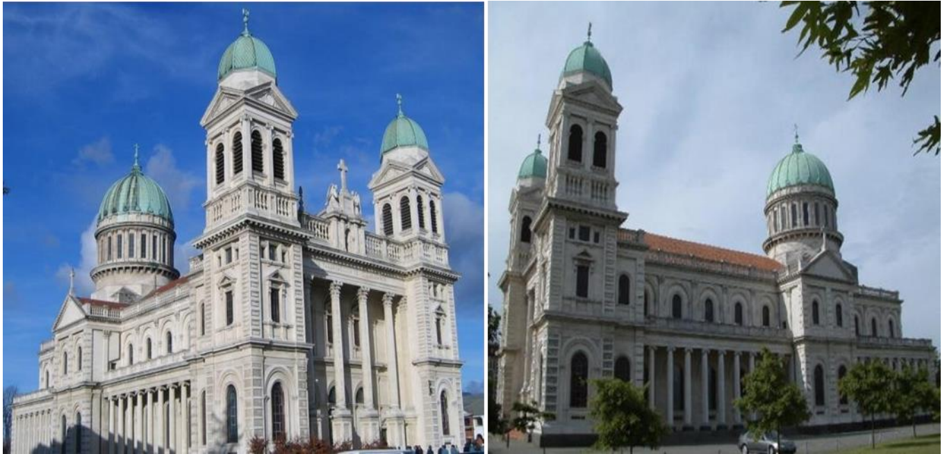
Figure II. 15 : Cathédrale du Saint-Sacramento: façades nord et ouest (à gauche); Façade sud (à droite).45].
