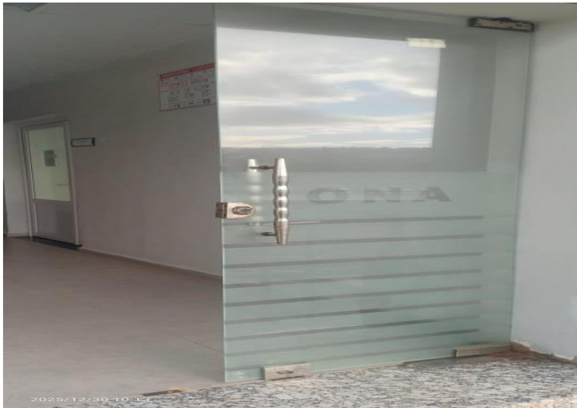
Figure 33. Entrée du laboratoire de-là station d'épuration Mostaganem
