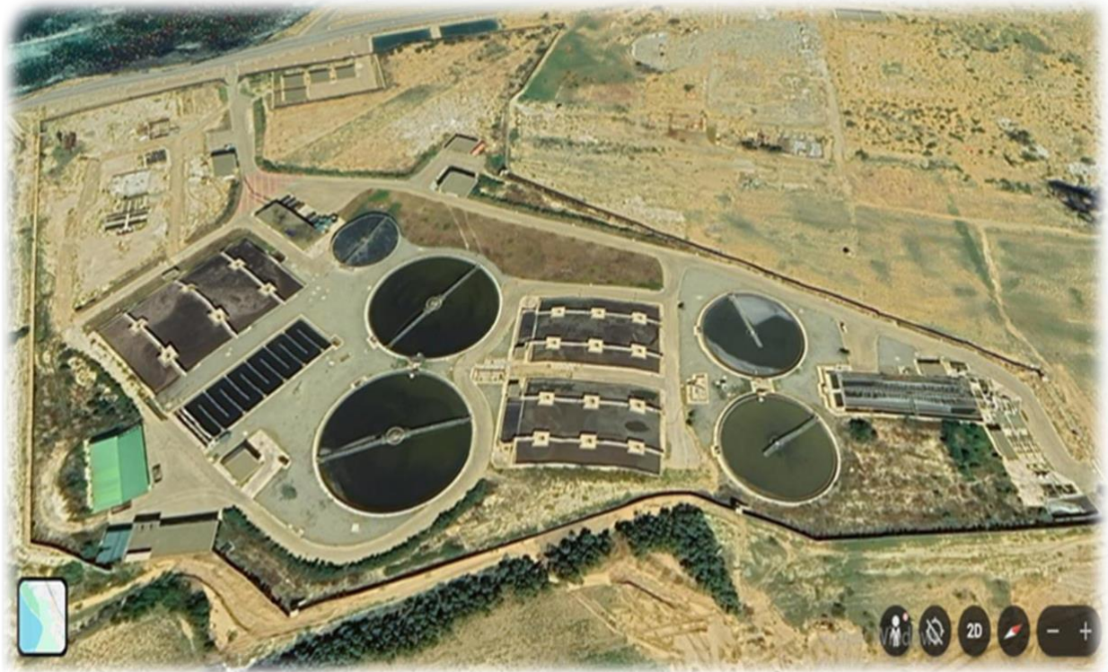
Figure 16. Vue aérienne de la station d'épuration de Mostaganem (Google Earth)
