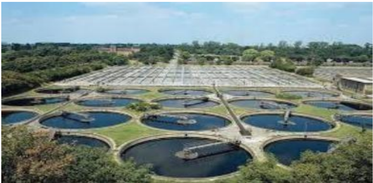
Figure 6 : Station d'épuration en Algérie (ONA, 2022).
