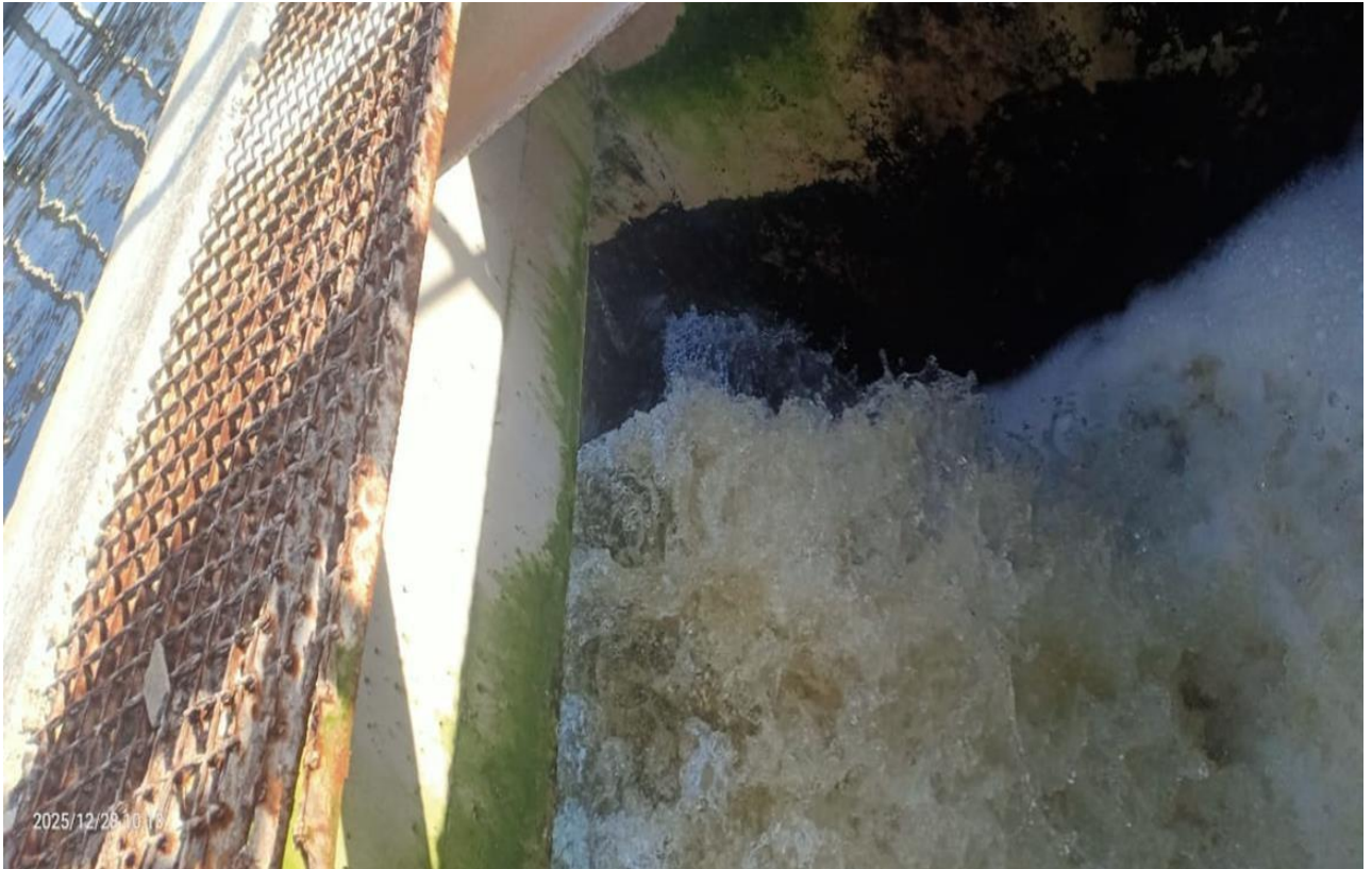
Figure 22. L'entrée des eaux usée pour le prétraitement
