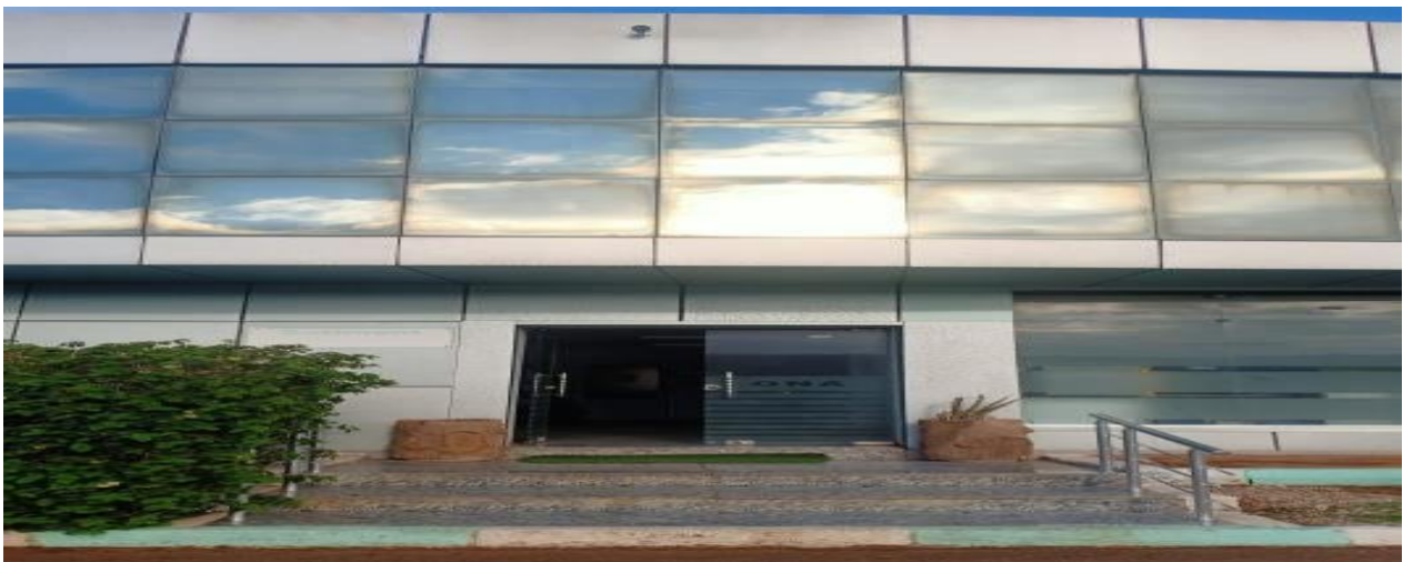
Figure 17. L'administration de laboratoire de la station d'épuration Mostaganem
