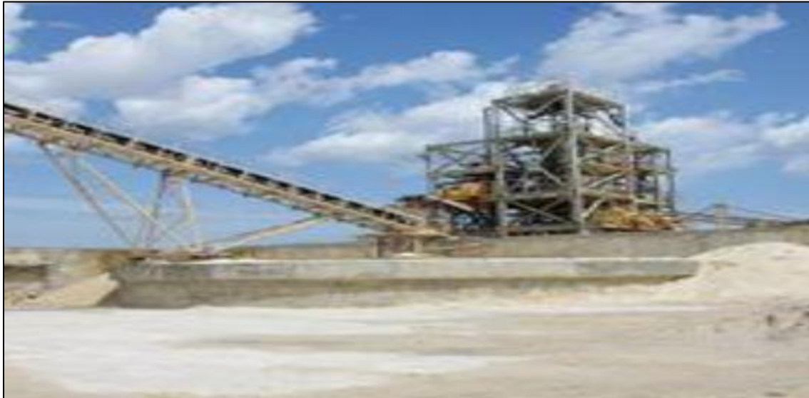
Figure I.5: Industrie de production de sable et dérivés
