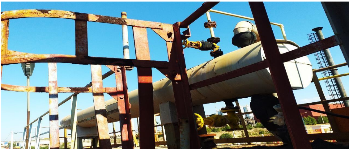
Figure II.25: Echangeur de chaleur tubulaire à calendre HE-162.
