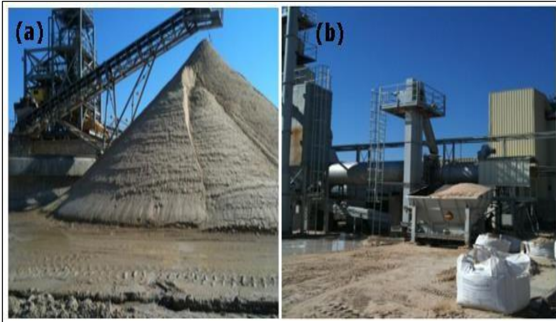
Figure I.6: Unité de traitement du sable industriel : (a) Lavage de sable, (b) Séchage de sable.
