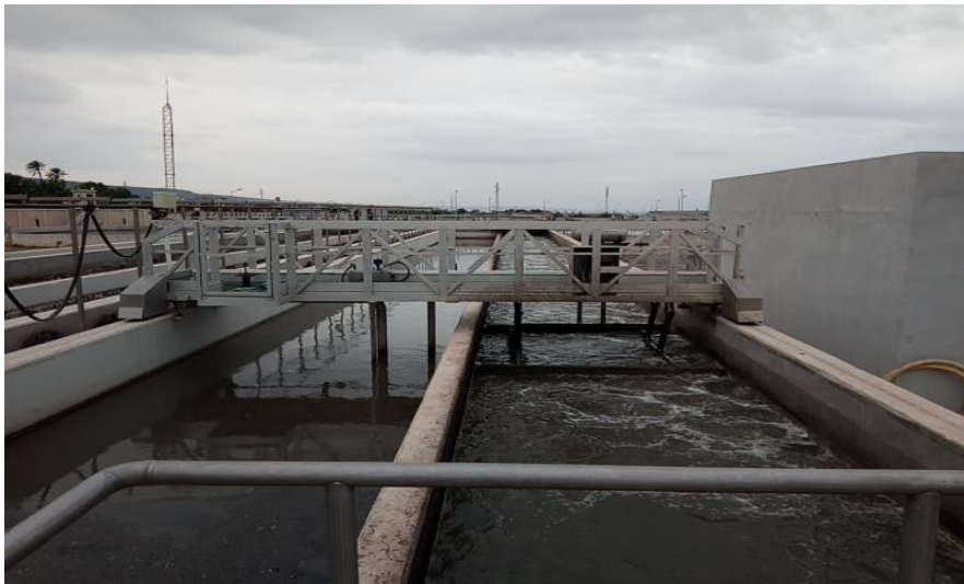
Figure II. 3 : dessableur-déshuileur. (STEP boues activées, Salamandre, Mostaganem)
