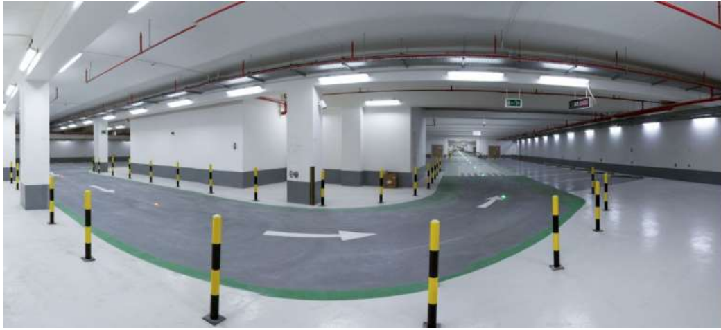
Figure 10 :Intérieur du parking multiniveaux de Lusail, Qatar [31]
