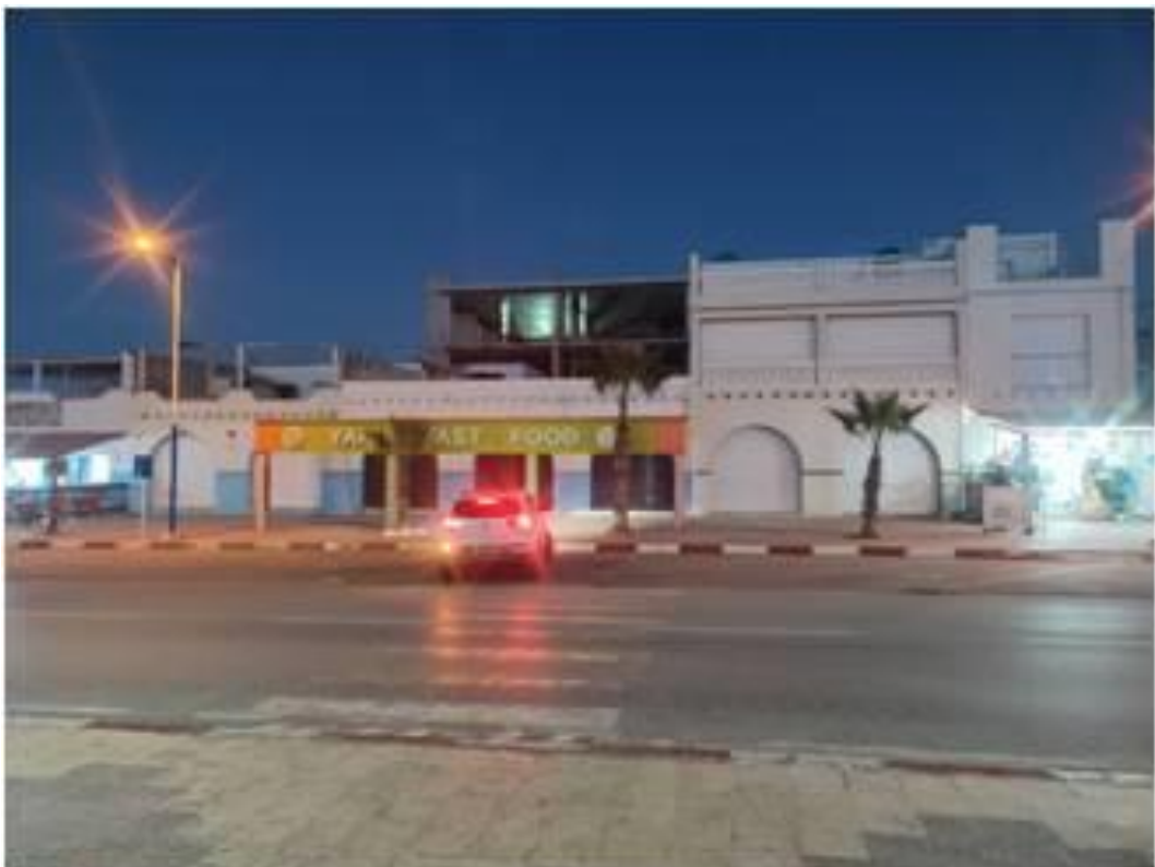
Figure 17: photo exprimé la facades de la plage des salettes Ammour,Ghelfmassi,Loumi, 2022
