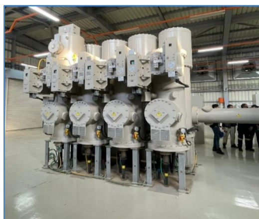
Figure 2.4 : Sous station III poste blindées (GAZ SF6)
