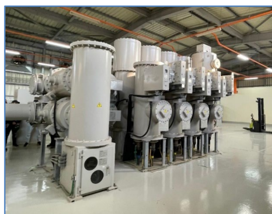
Figure 2.4 : Sous station III poste blindées (GAZ SF6)
