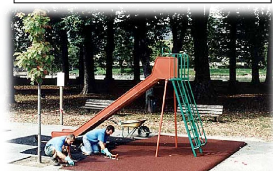
Pose d'une couche de finition
