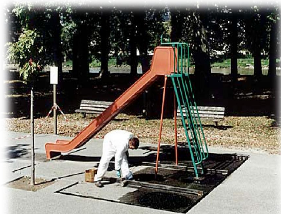
Sol coulé : couche d'accroche
