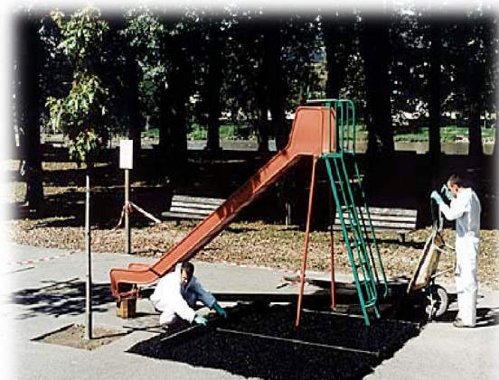
Pose d'une sous-couche
