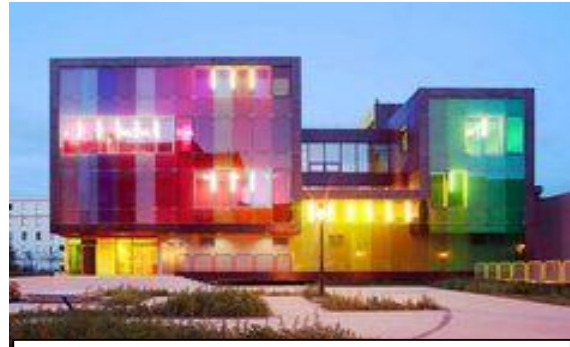
Figure4.9: Le centre sportif pour enfant à Saint Cloud
