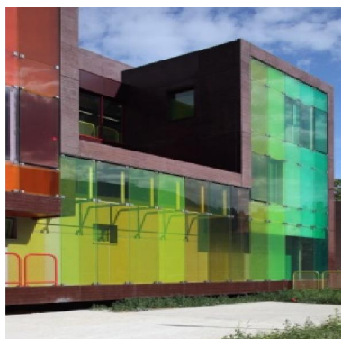
Figure4.11 : Façade en panneaux de verre
