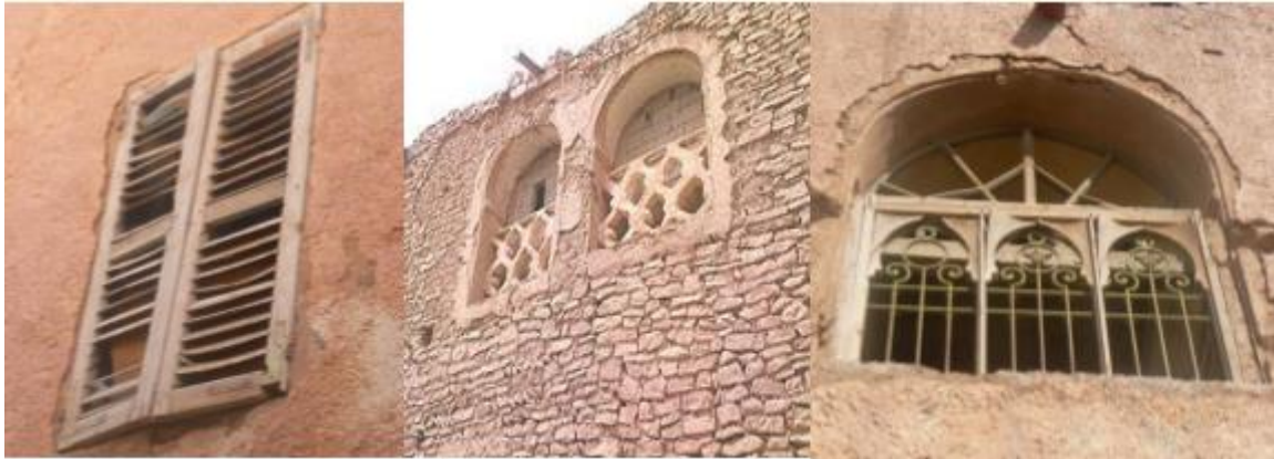
Figure 36 : quelque type de fenêtres source : photo prise par l'auteur
