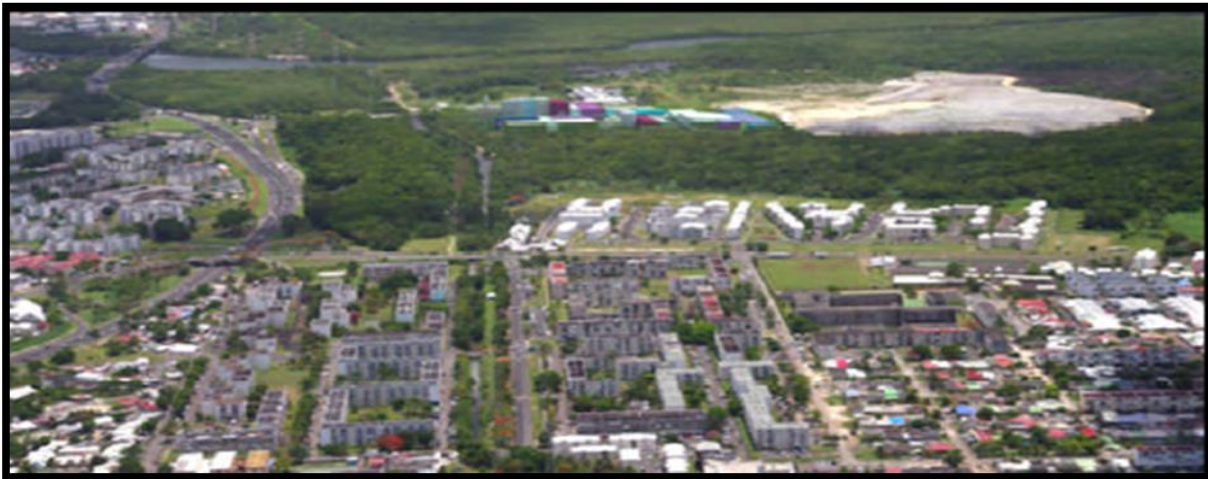
Figure : vue aérienne du projet
