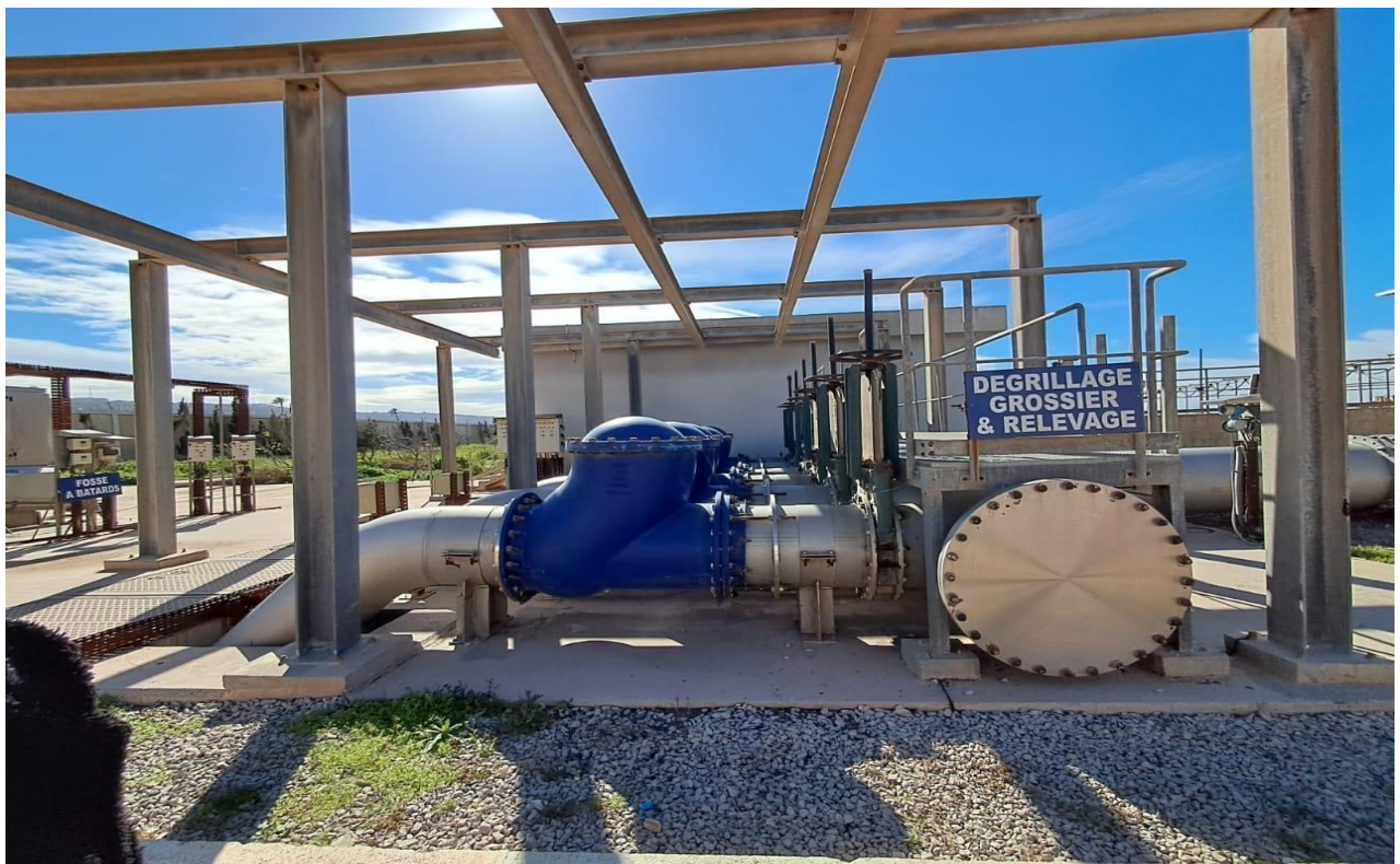
Figure II.5 : Dégrillage grossier.
