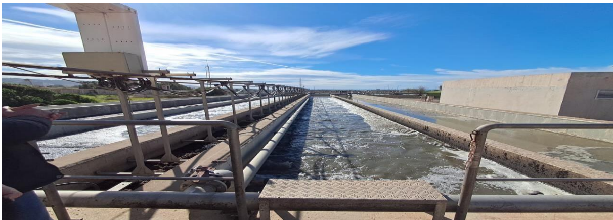
Figure II.6 : Dessablage-Déshuilage.
