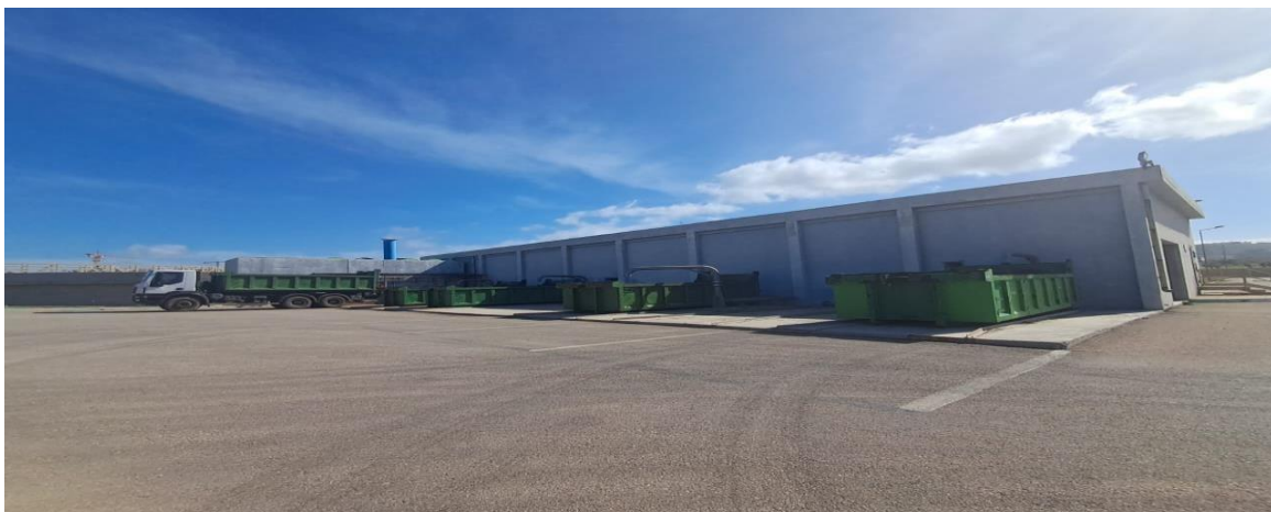
Figure II.14 : Stockage de boues déshydratées.
