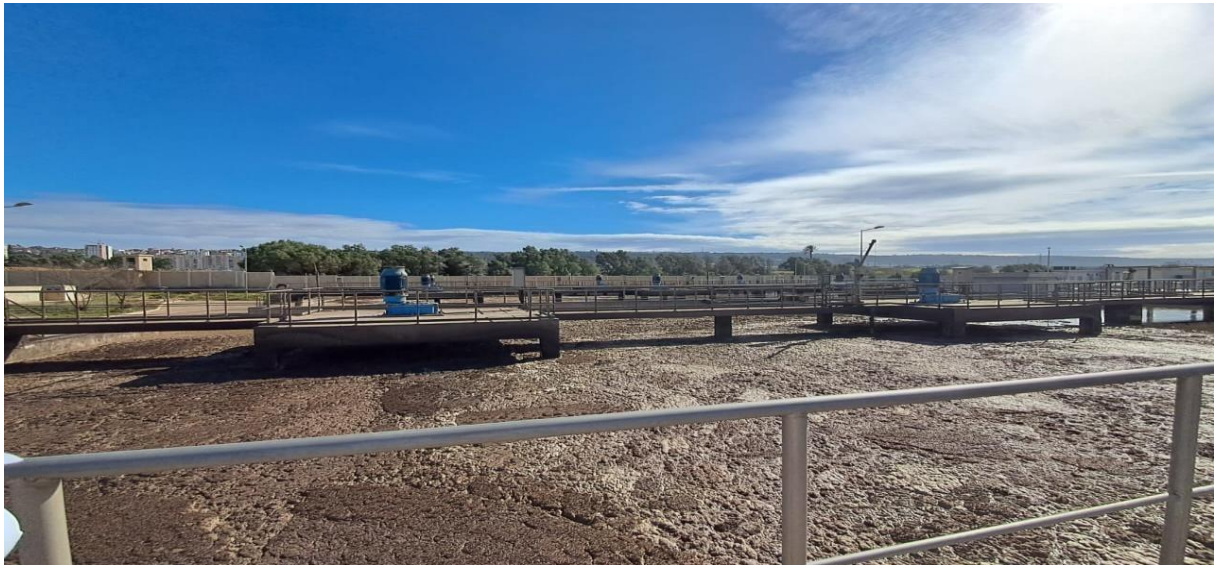
Figure II.8 : Bassin biologique (Bassin d'aération).
