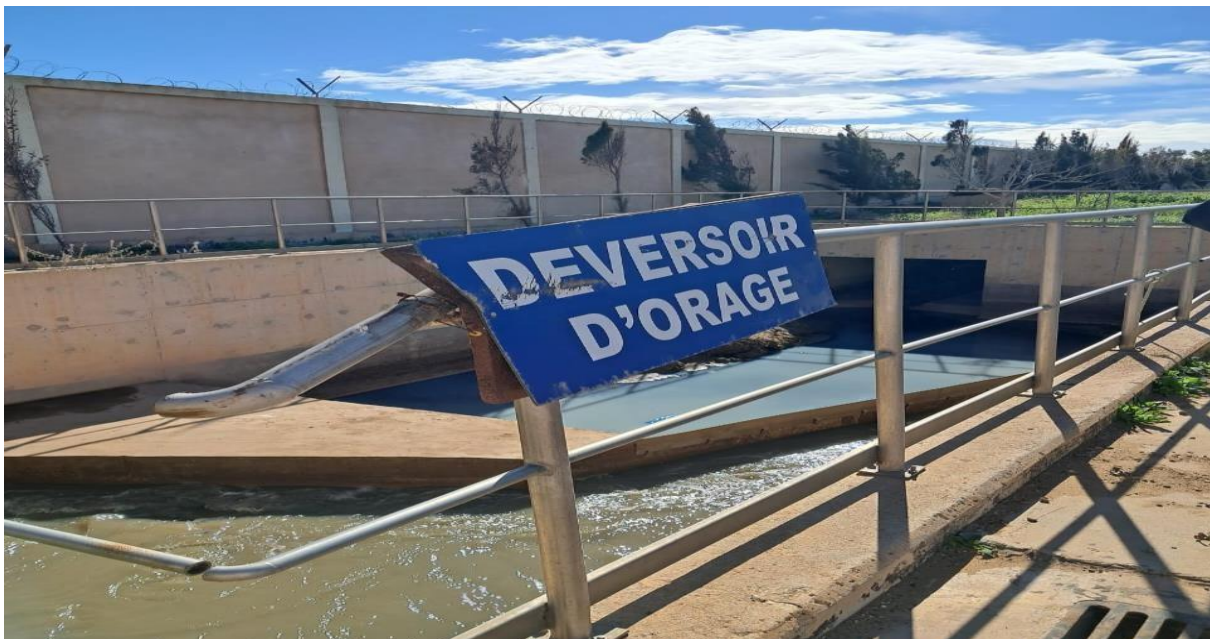
Figure II.4 : Déversoir d'orage.
