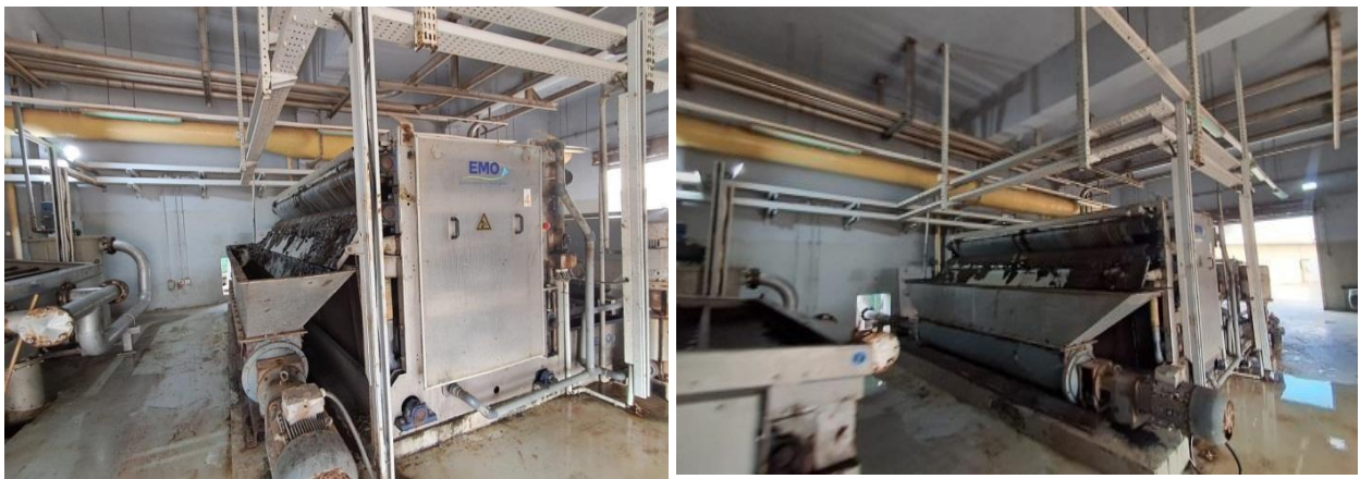
Figure II.13 : Section de déshydratation.
