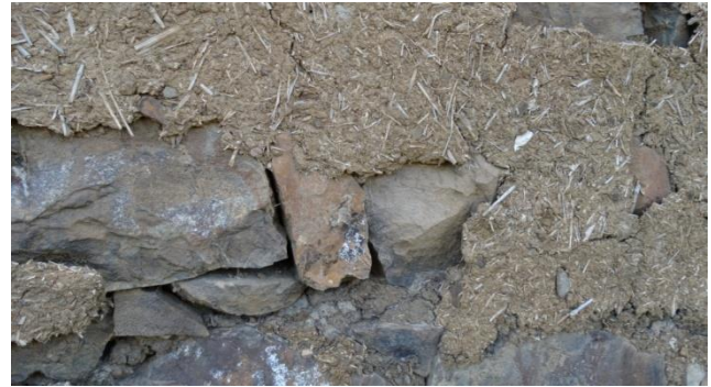
fig28- Mur crépi en terre - Source auteur
