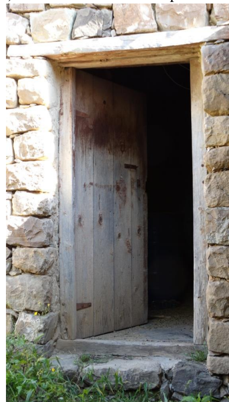
Fig59 Détail linteau et seuil en bois.
