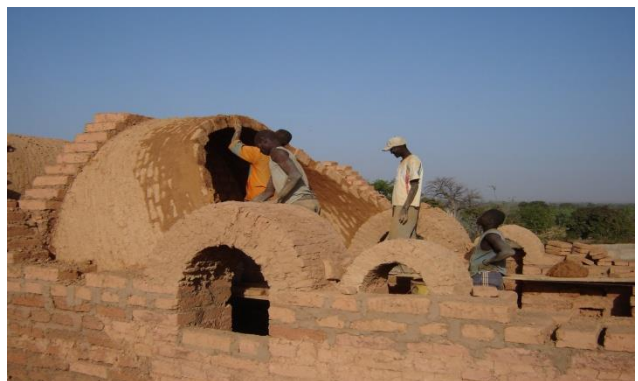
Fig 34- Construction voute nubienne-Source inconnue
