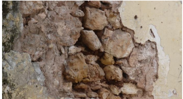
Fig31-Mur en pierre avec liant en terre avec crépissage ciment/sable- source : auteur
