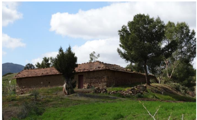
Fig50-Maison (Beni djertene) Source auteur
