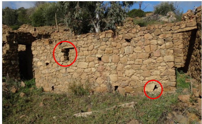
Fig55: Mur d'une étable donnant sur la cour Boukaid
