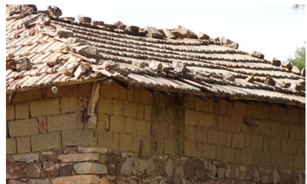
Fig62-Murs mixte pierre/adobe- (source : auteur
