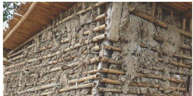
Fig29-Torchis sur roseau source : F.Monier-J
