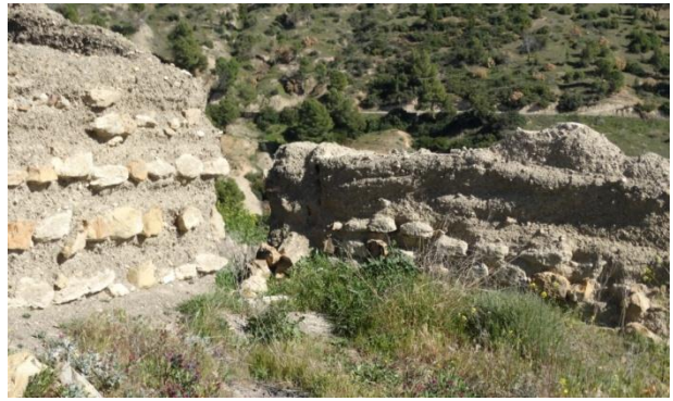
fig32 Mur en pisé –source : auteur
