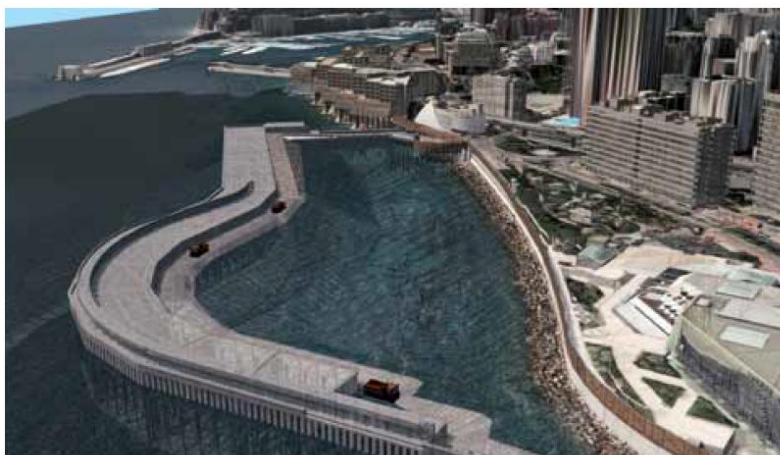
Figure 73 : L'emprise de l'extension après la pose des caissons et la fermeture du site
