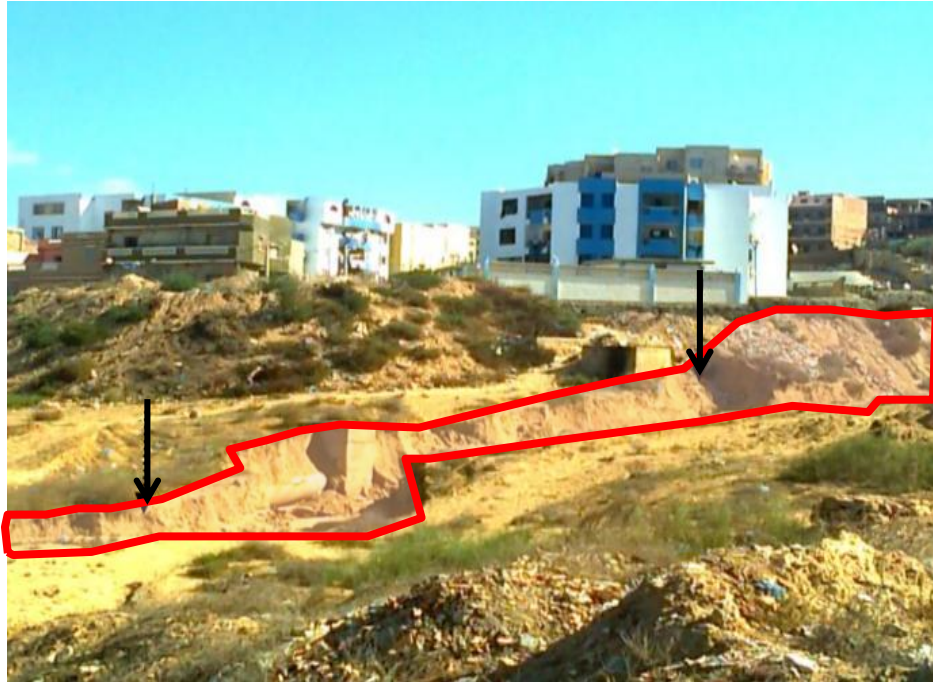
Figure 30 : Le passage de Chaabat de kharouba en plein axe de la ZEST et les traces de crues
