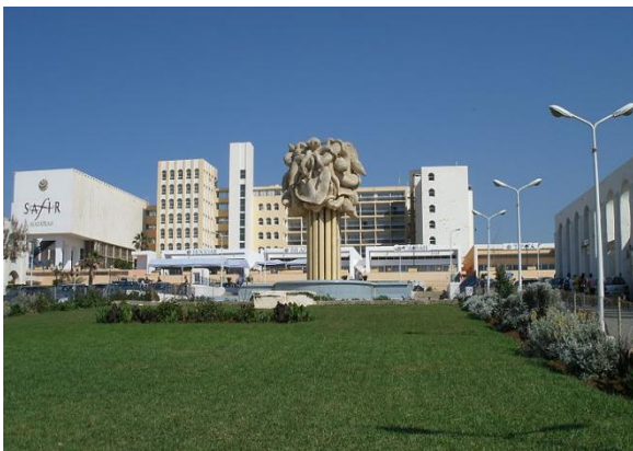
Figure 61 : Façade urbaine de l'Hôtel Mazafran
