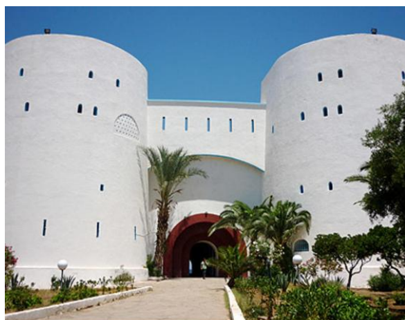
Figure 22 : la résidence hôtelière de Matarès (1971), À Tipaza, Pouillon
