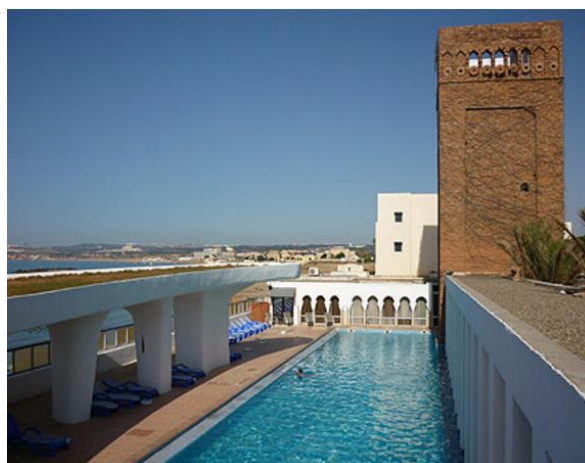
Figure 21 : l'hôtel Riad de Sidi Fredj (30 km d'Alger) (1968), Pouillon
