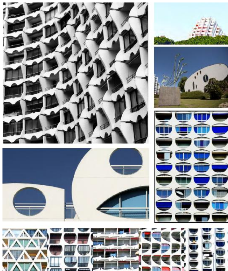
Figure 81 : Les dispositions architecturales des bâtiments de la station
