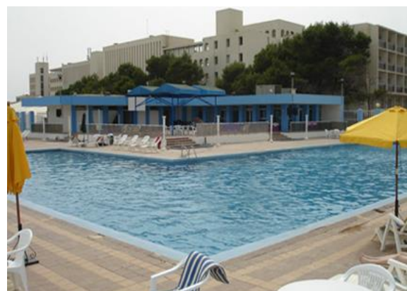
Figure 60 : Piscine en plein air
