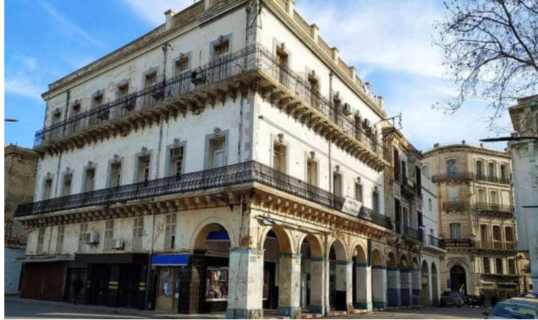
Photo 2- 37: Photo d'un immeuble post-haussmannien. Source: Auteur.
