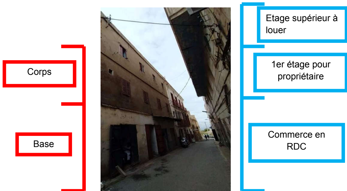
Photo 2- 33: Photo des immeubles (Rue HASSAINE Mustapha). Source: Auteur.
