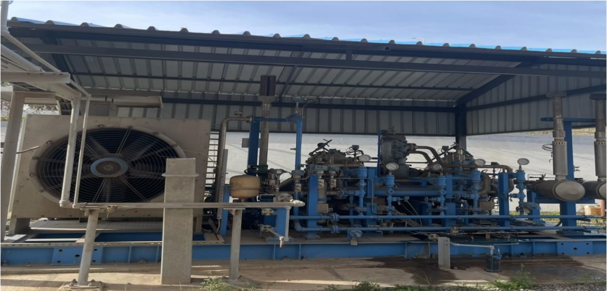
Figure II-9: Compresseur d'air NIXOX
