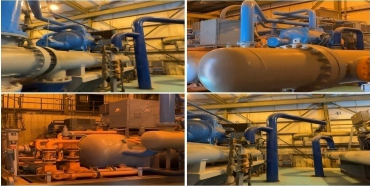
Figure II-2 : Le compresseur de charge
