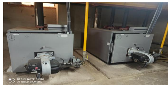
Figure 2.8 : Chaudière utilisé dans l'hôtel
