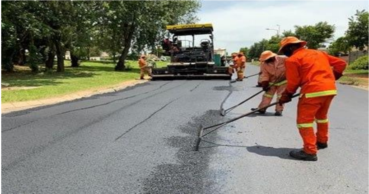
Figure III. 3: Réparations de Flache
