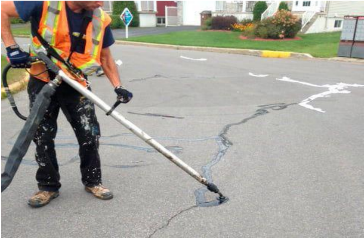
Figure III. 6: Réparations des Fissures transversales
