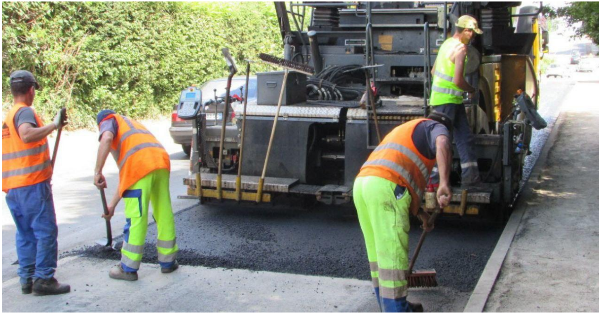
Figure III. 2: Réparations d'affaissement
