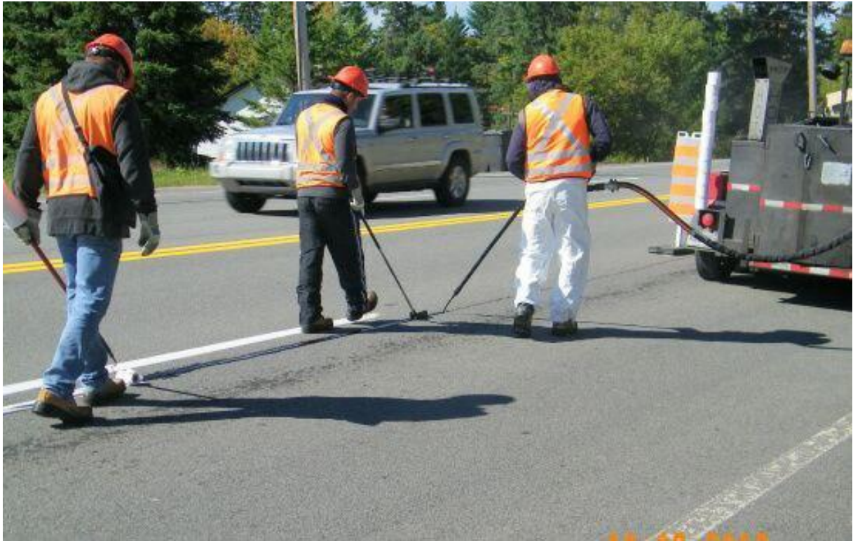
Figure III. 5: Réparations des Fissures longitudinales
