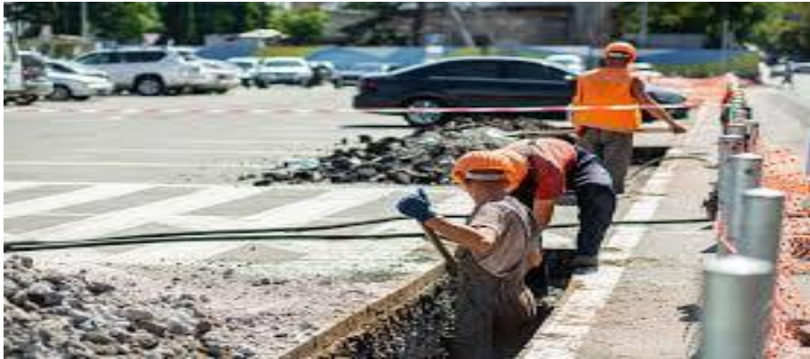
Figure II.9 : Les tranchées d'inspection
