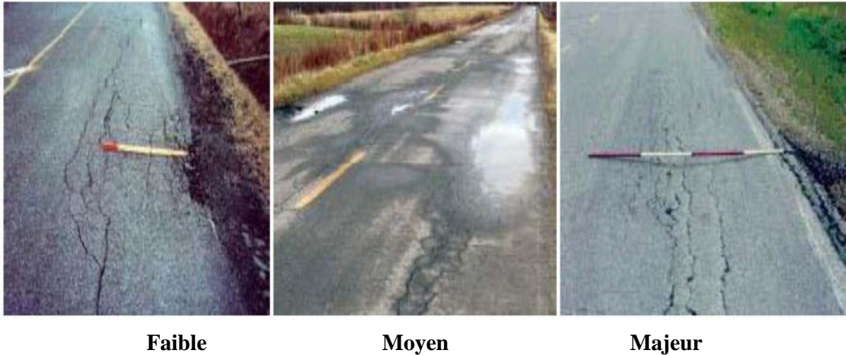
Figure I.9 : Affaissement de rives
