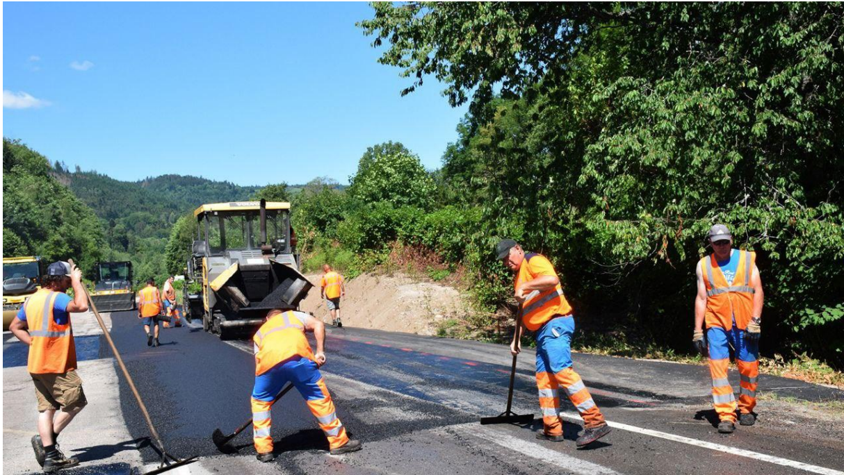
Figure III. 4: Réparations d'Orniérage
