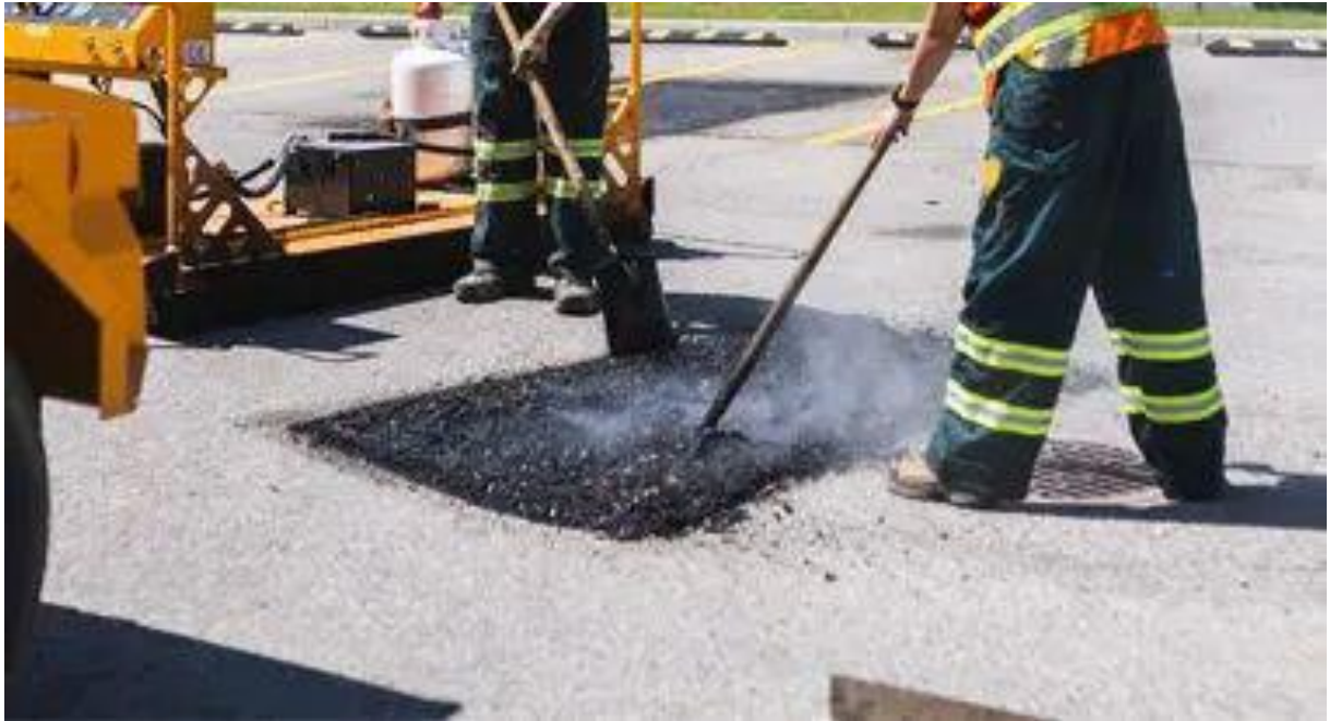
Figure III. 9: Réparations de pelade
