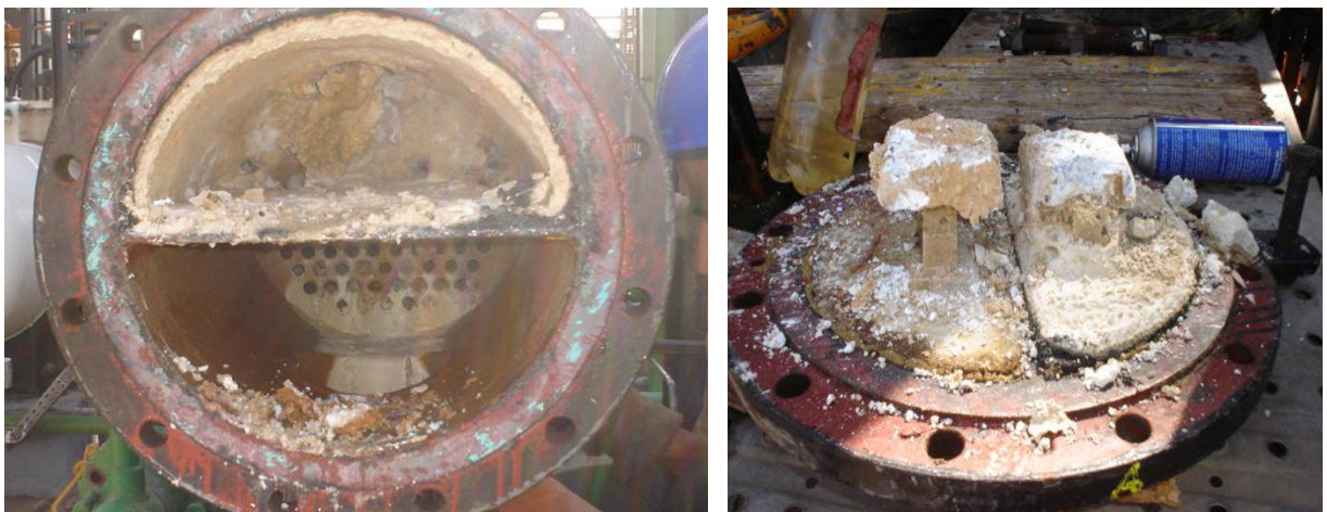
Figure III.3 : Les tartres formés sur la boîte de distribution.
