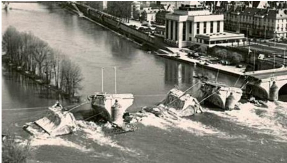
Figure 0.3: L'affouillement général (a) Schémas du phénomène d'affouillement général (b) Exemple d'affouillement général du pont Wilson à Tours, 1978 (Cerema 2019)
