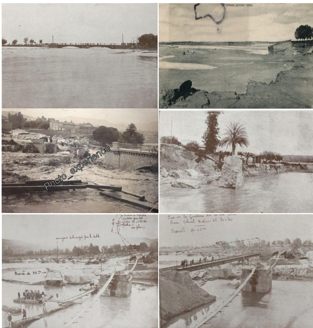
Figure 0.8: Les dégâts enregistrés dans la wilaya de Mascara suite aux crues de 1927 : (a) pont de la plaine d'El Habra pendant la crue avant sa destruction (b) le pont de la plaine d'El Habra détruit après la crue, (c) la destruction d'un pont à Bouhnifia, (d) le reste de la culée rive gauche du pont de Hacine, (e, f) destruction du pont d'El Guetna sur oued El Hammam (Source : photos d'archives).
