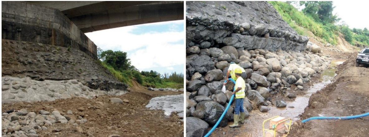
Figure 0.4: Protection d'une culée par paroi moulée surmontée d'une couche d'enrochements liés disposée sur la pente de berge (Source : Cerema 2019)
