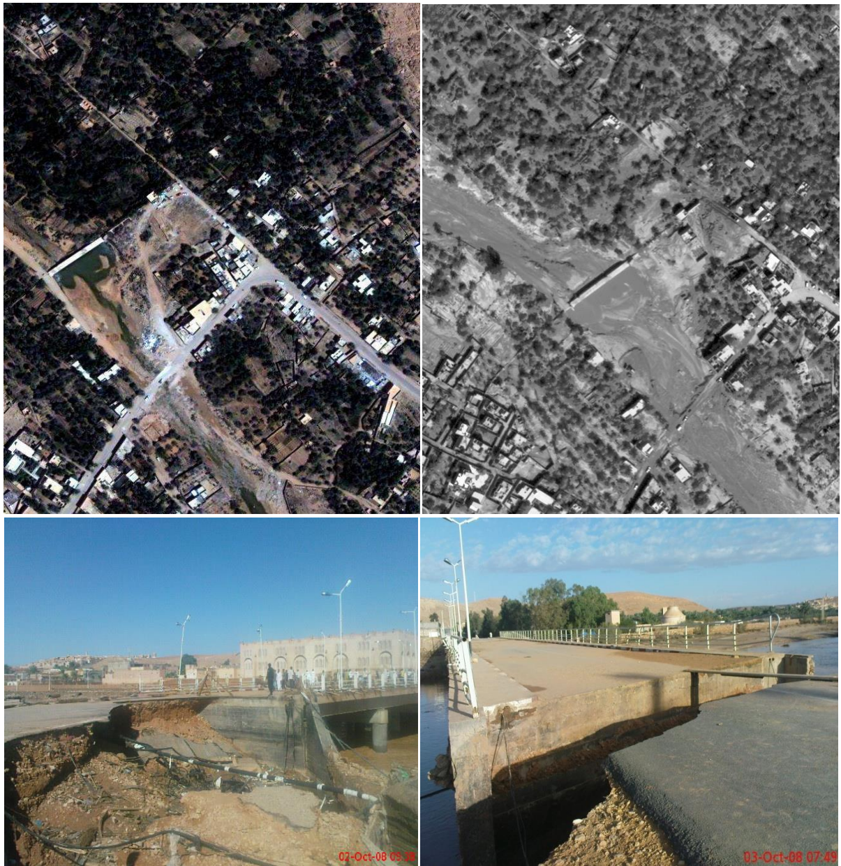
Figure 0.6: Dégâts causés sur les ponts le long de la vallée (source : Benzahaf et Salem, 2010)
