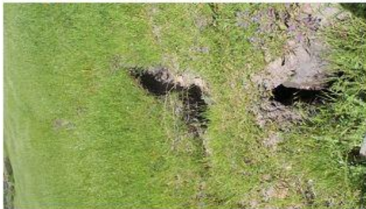
Photo 05. Érosion interne affaissement
