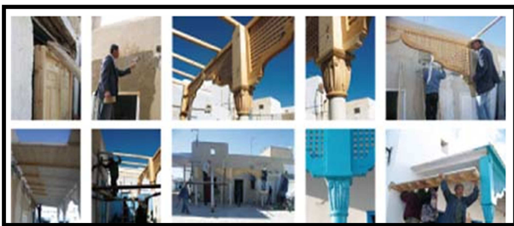
Figure 36 travaux de aménagement / www.rehabimed.net
