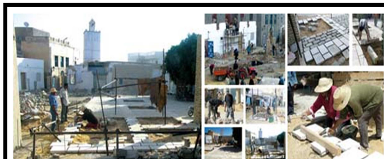
Figure 34 les travaux de l'aménagement de la place /www.rehabimed.net
