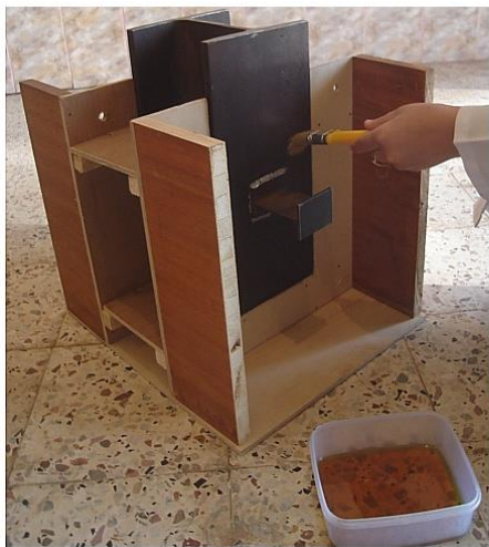
Photo 2.3 : Huilage des semelles et disposition des barres d'armature
