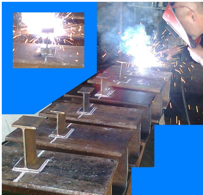
Photo C1 : Fixation des connecteurs par soudure
