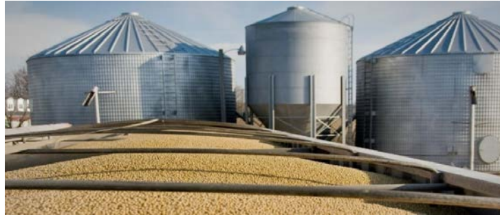
Figure I-8 : Silos de stockage de matériaux en vrac [3]
