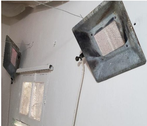
Figure 31 : installation des éleveuses
