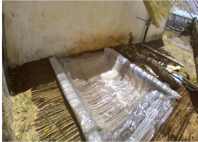
Figure 12 : mise en place de la bâche (photo originale)
