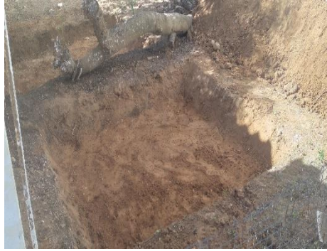
Figure 9 : creusement des bassins (photo originale)
