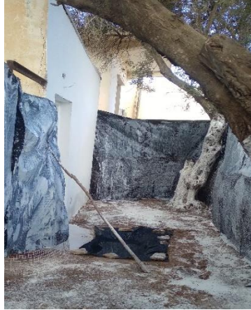
Figure 29 : structure contre les courants d'air (photo originale)
