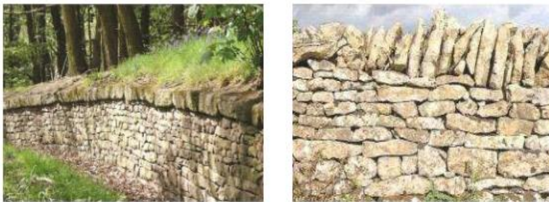
Figure 1.6 : Couronnement des murs en pierre sèche : en grosses pierres plates à gauche, en clavage à droite
