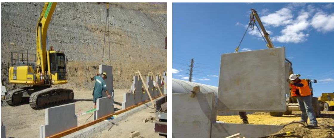
Figure 2.13 : Mise en place des écaillés de parement
