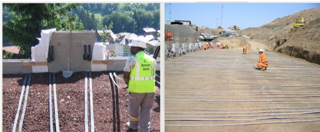
Figure 2.14 : Mise en place des armatures
