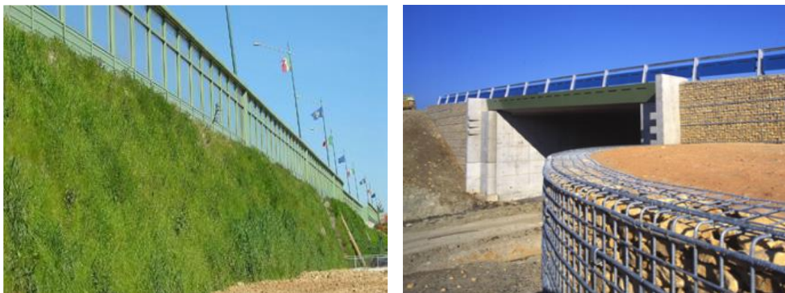
Figure 2.9 : Parement de type TerraTrel
