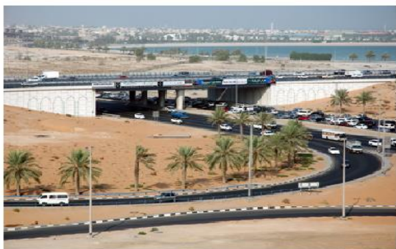
a- Ouvrages routiers
