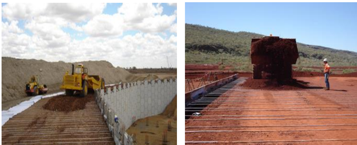
Figure 2.15 : Remblayage et compactage
