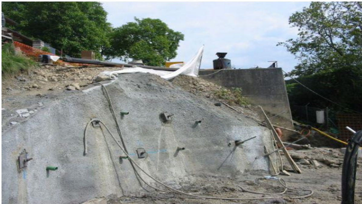
Figure 1.28 : Massif cloué en site montagneux
