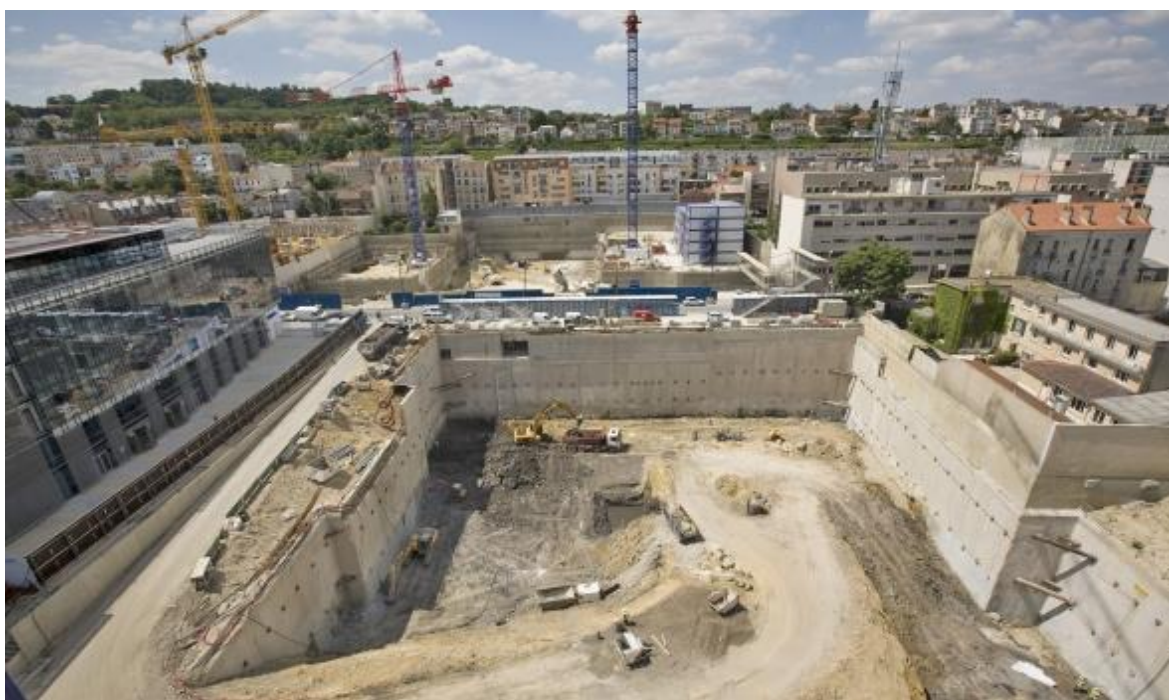
Figure 1.25 : Paroi moulée pour une construction urbaine
