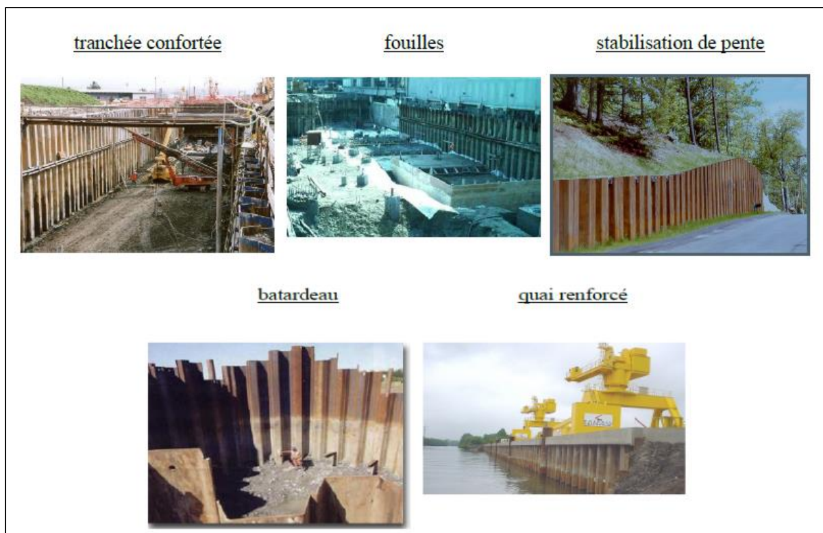
Figure 1.14 : Domaine d'application des rideaux de palplanches
