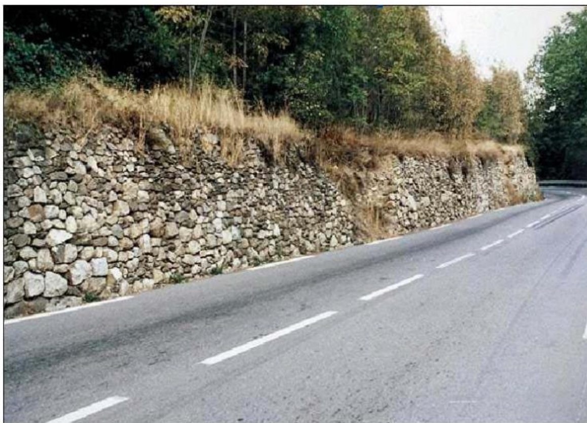
Figure 1.1 : Mur en maçonnerie de pierres sèches
