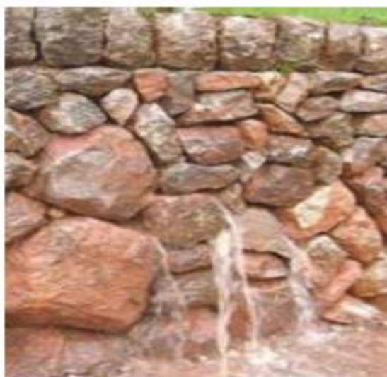
Figure 1.5 : écoulement des eaux pluviales à travers un mur en pierres (le drain)
