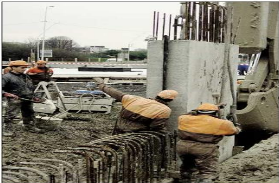
Figure 1.22 : Mise en place d'une paroi préfabriquée
