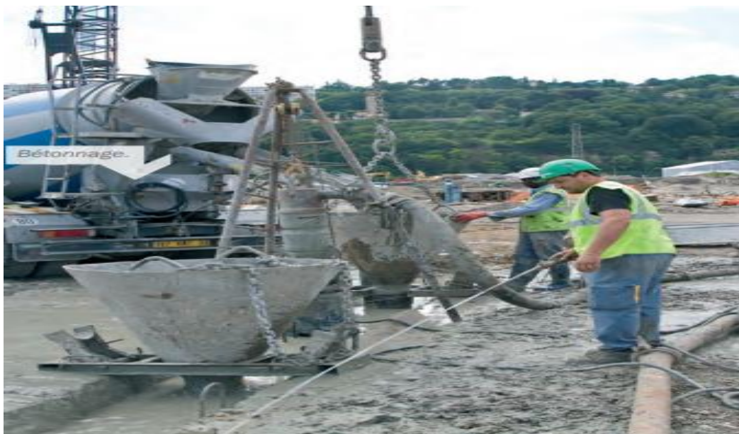
Figure 1.21 : Paroi moulée coulé en place
