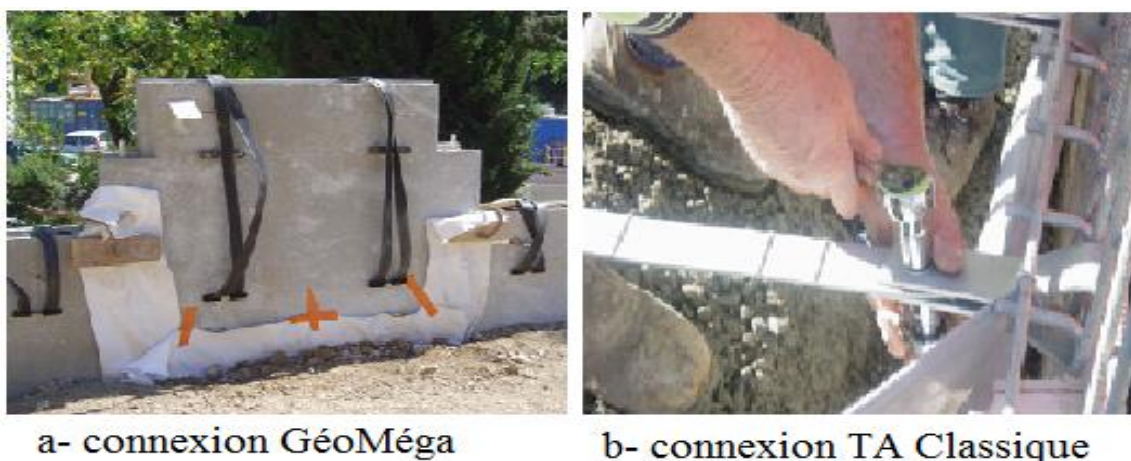
Figure 2.11 : Systèmes de connexion entre panneaux et armatures
