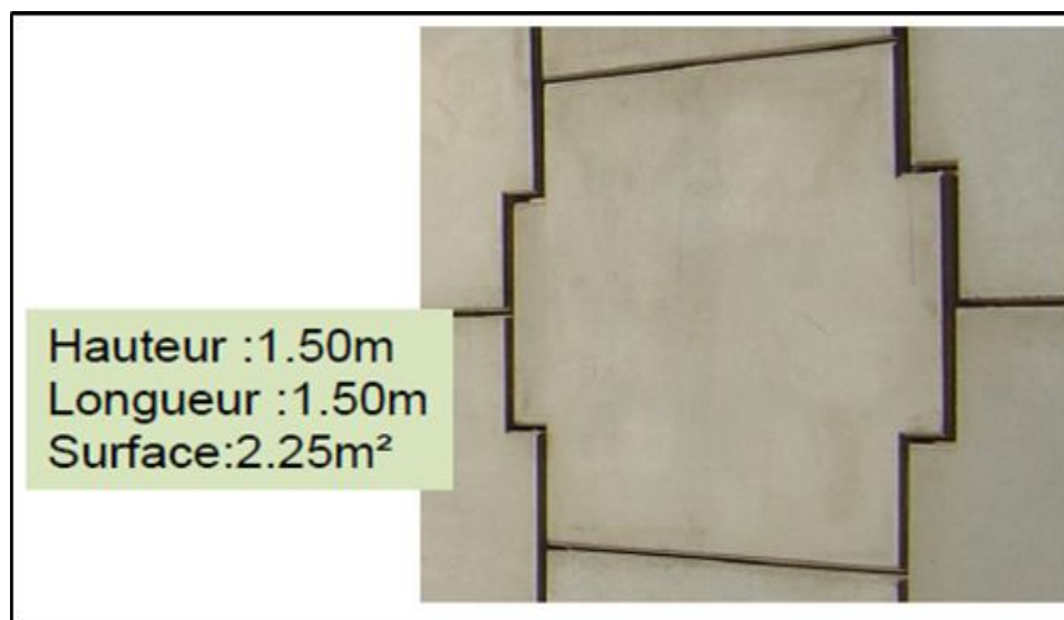
Figure 2.8: Écaille cruciforme standard préfabriquée en béton
