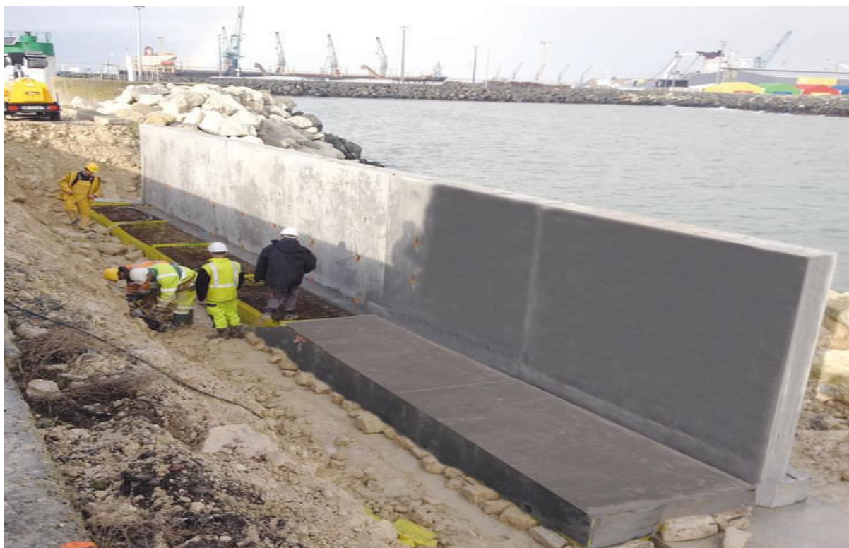
Figures 1.10: Mur de soutènement en béton armé coulé en place
