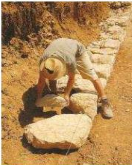
Figure 1.4 : Pose des pierres de socle
