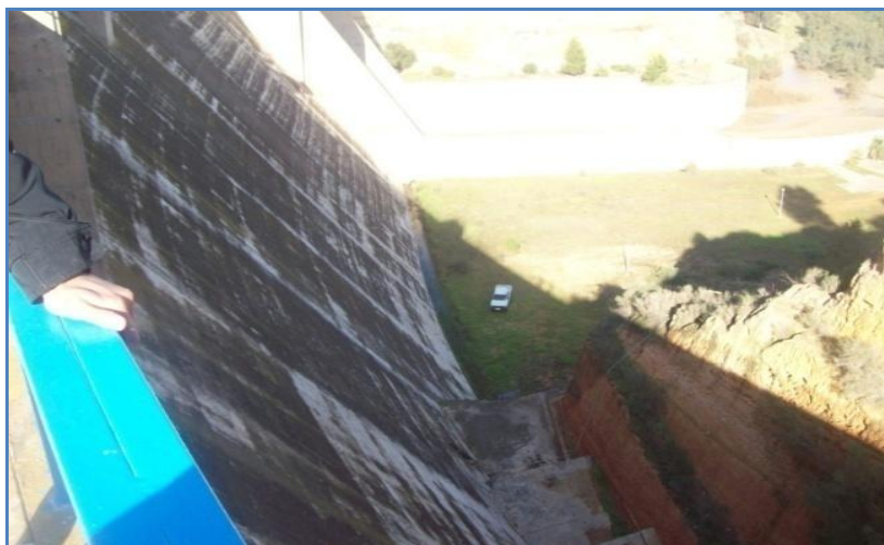
Figure I.37 : Vue du coté interne de la digue du barrage Chorfa
